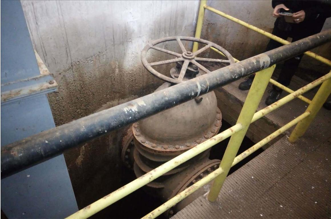
Figura 5 – Torre di presa del Liscia – Saracinesca della prima bocca di presa
