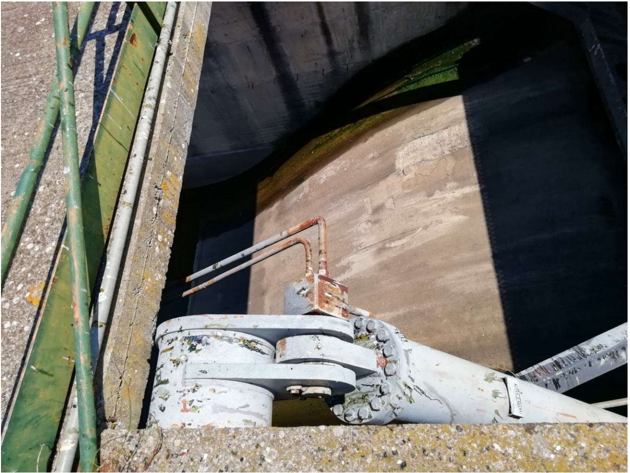
Figura 12 PARTICOLARE TRASDUTTORE POSIZIONE PARATOIA 1
