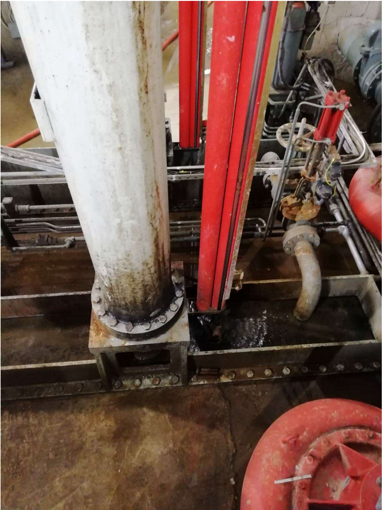
Figura 10 PARTICOLARE ASTE DI SEGNALAZIONE PARATOIE SCARICO DI FONDO - DA REVISIONARE
