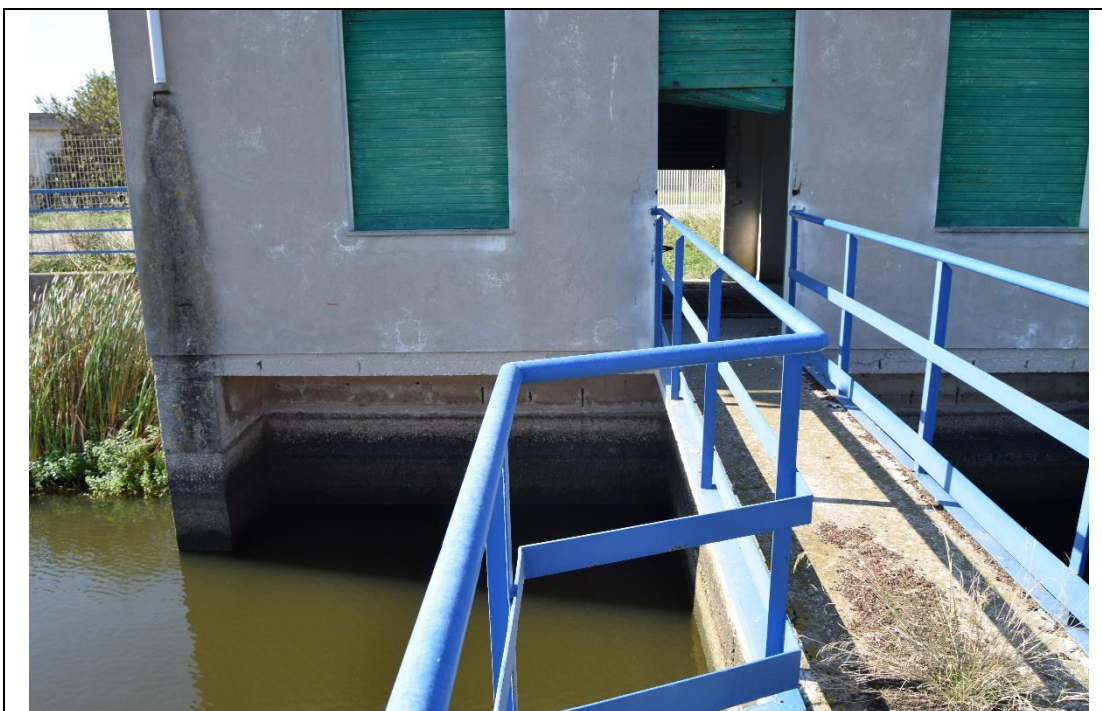
Figura 3-37: Manufatto di presa-prospetto lato vasca sx – stato di degrado della struttura
