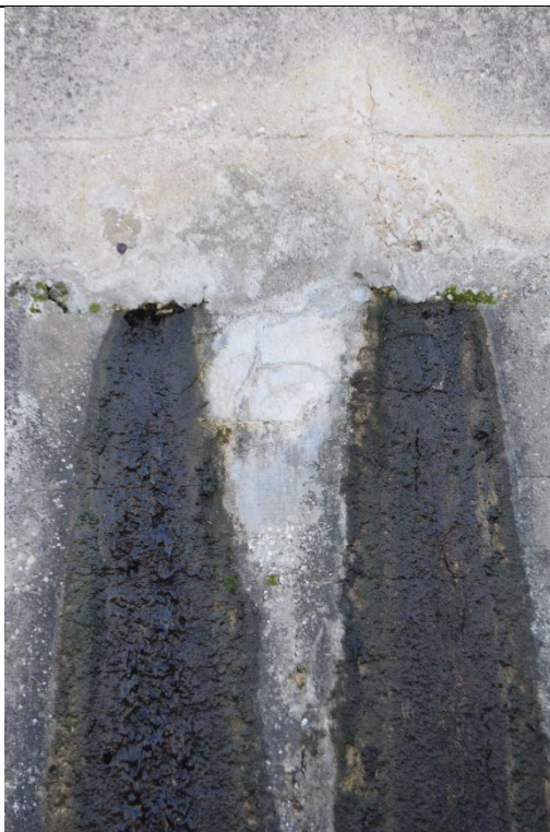
Figura 5-16: Vasca dx - perdita di acqua
