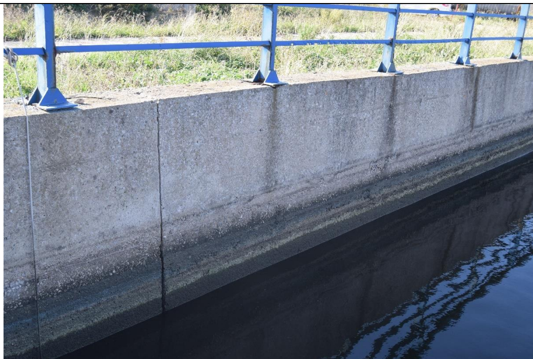
Figura 3-7: Vasca sx stato di degrado delle strutture della parete perimetrale (giunto di dilatazione)
