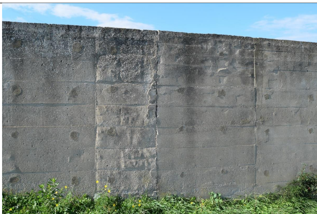
Figura 4-12: paramento perimetrale esterno vasca sx - stato degrado strutture
