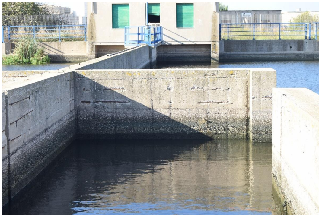
Figura 3-21: Vasca dx - Particolare dello stato di degrado delle strutture del setto ingresso
