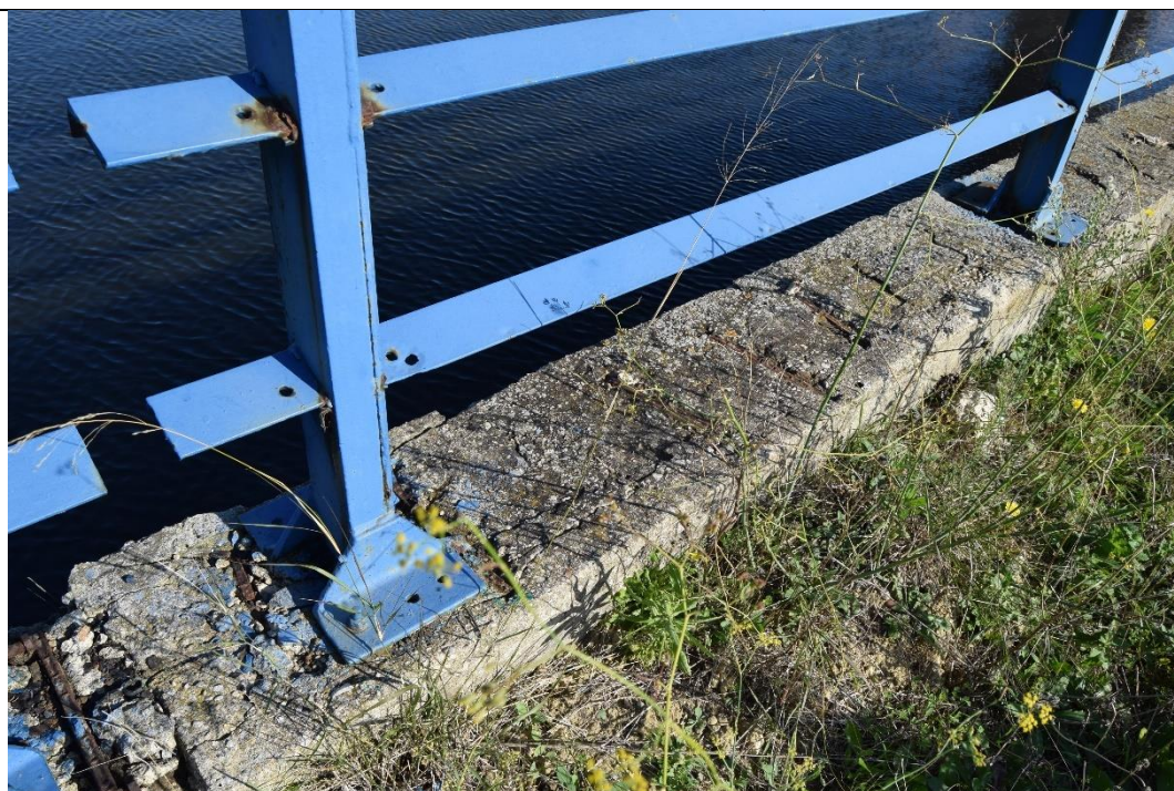
Figura 3-4: Vasca sx – stato di degrado delle strutture della parete perimetrale
