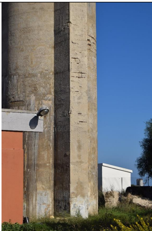
Figura 3-42: Torrino piezometrico - stato di degrado delle strutture
