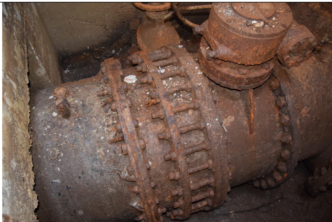
Figura 3-55: Interno camera partizione - stato di degrado del piping
