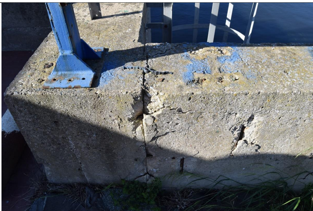
Figura 3-22: Vasca dx - Particolare dello stato di degrado delle strutture del muro perimetrale
