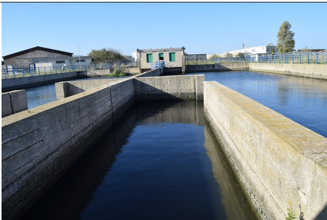
Figura 3-19: Vasca dx - stato di degrado delle strutture del setto ingresso
