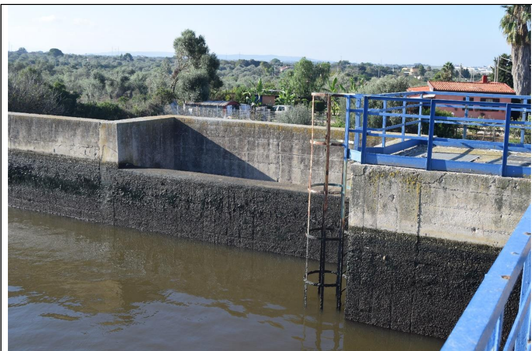
Figura 5-29: vasca di sx: stato di degrado del calcestruzzo in corrispondenza dello sfioro
