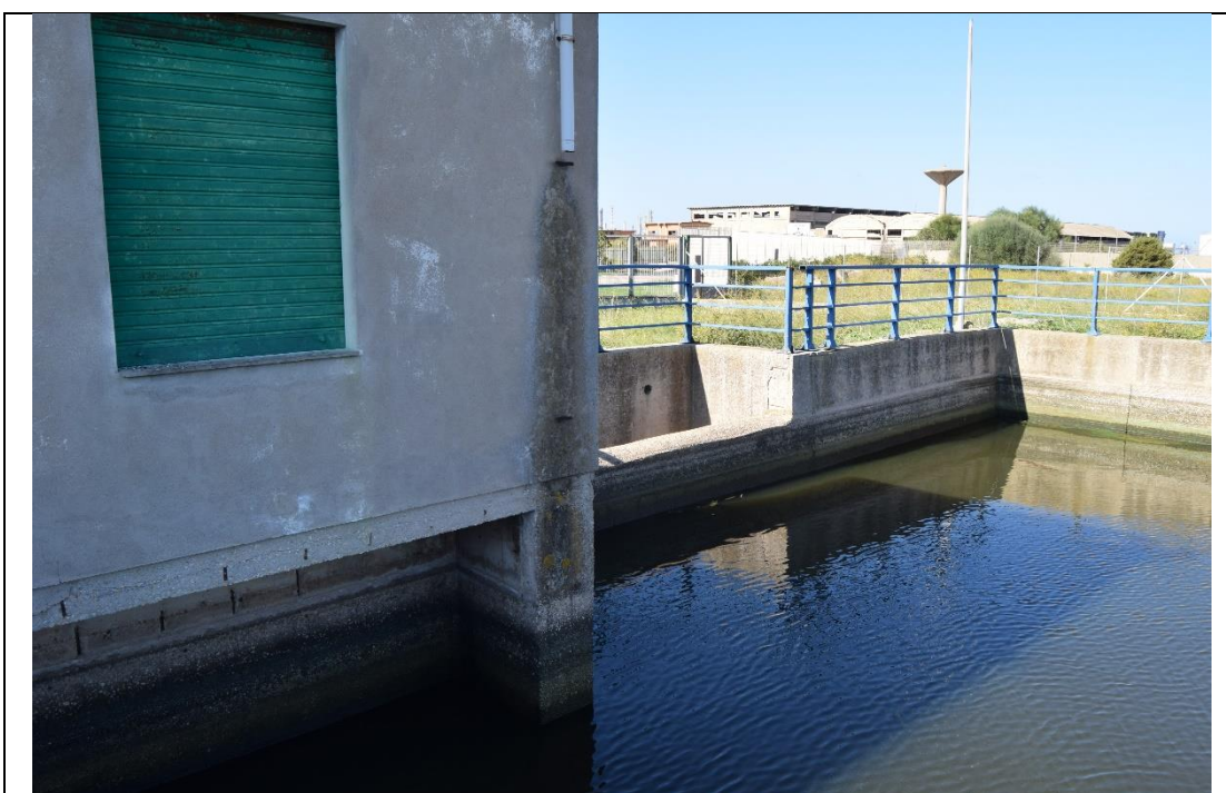
Figura 3-38: Manufatto di presa-prospetto lato vasca dx – stato di degrado della struttura
