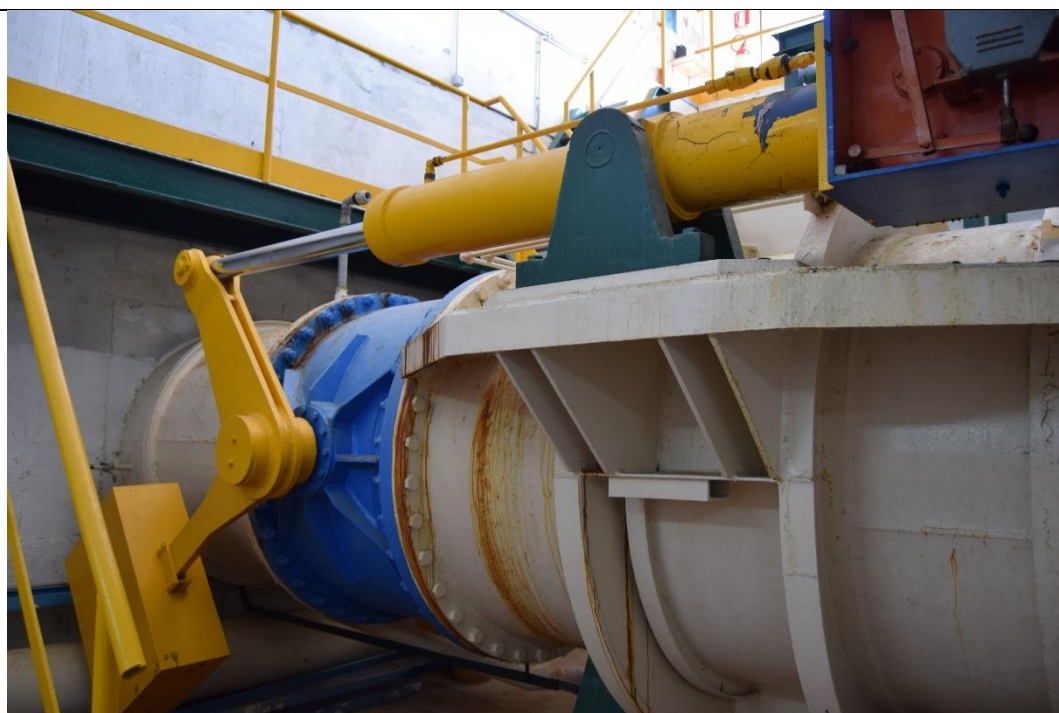
Figura 3-62: Camera manovra: valvola a farfalla sulla tubazione ingresso DN1400
