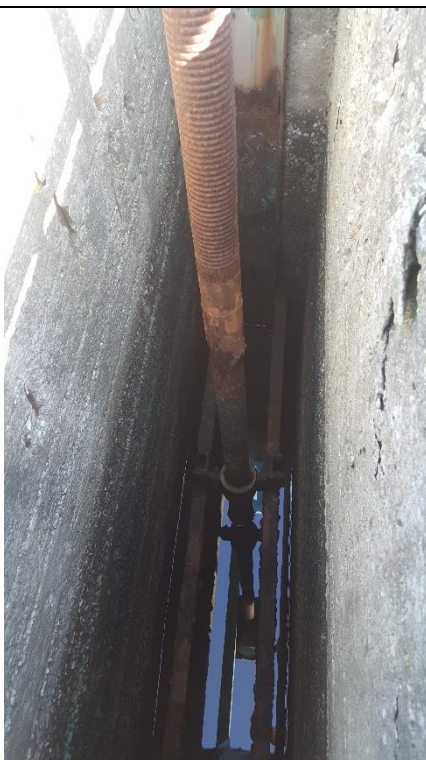
Figura 3-35: setto divisorio tra le vasche – stato di consistenza del vano di alloggio della paratoia esistente
