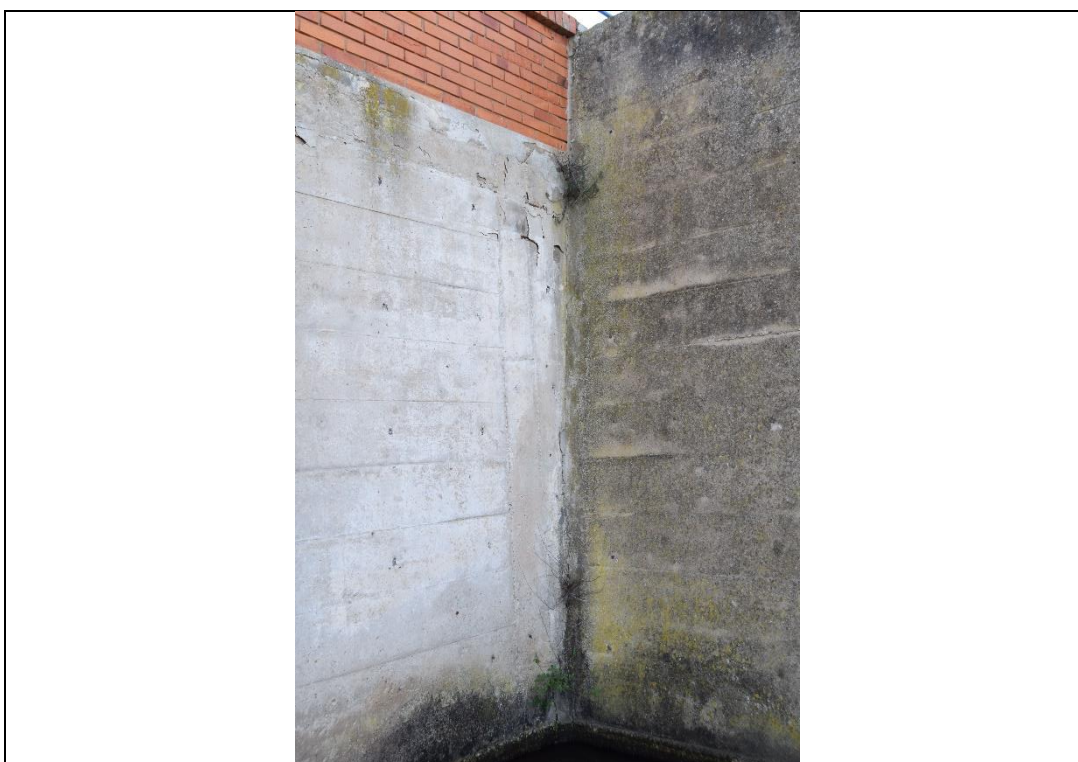
Figura 5-8: Spigolo tra camera di manovra e vasca dx: stato di degrado del calcestruzzo esterno
