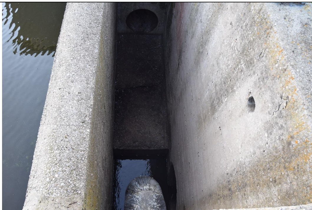
Figura 3-29: Vasca dx- soglia di sfioro in uscita – vista della foronomia e del piping
