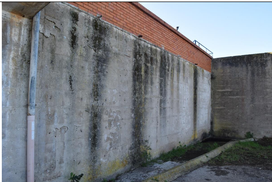
Figura 5-7: Camera di manovra: stato di degrado del calcestruzzo esterno
