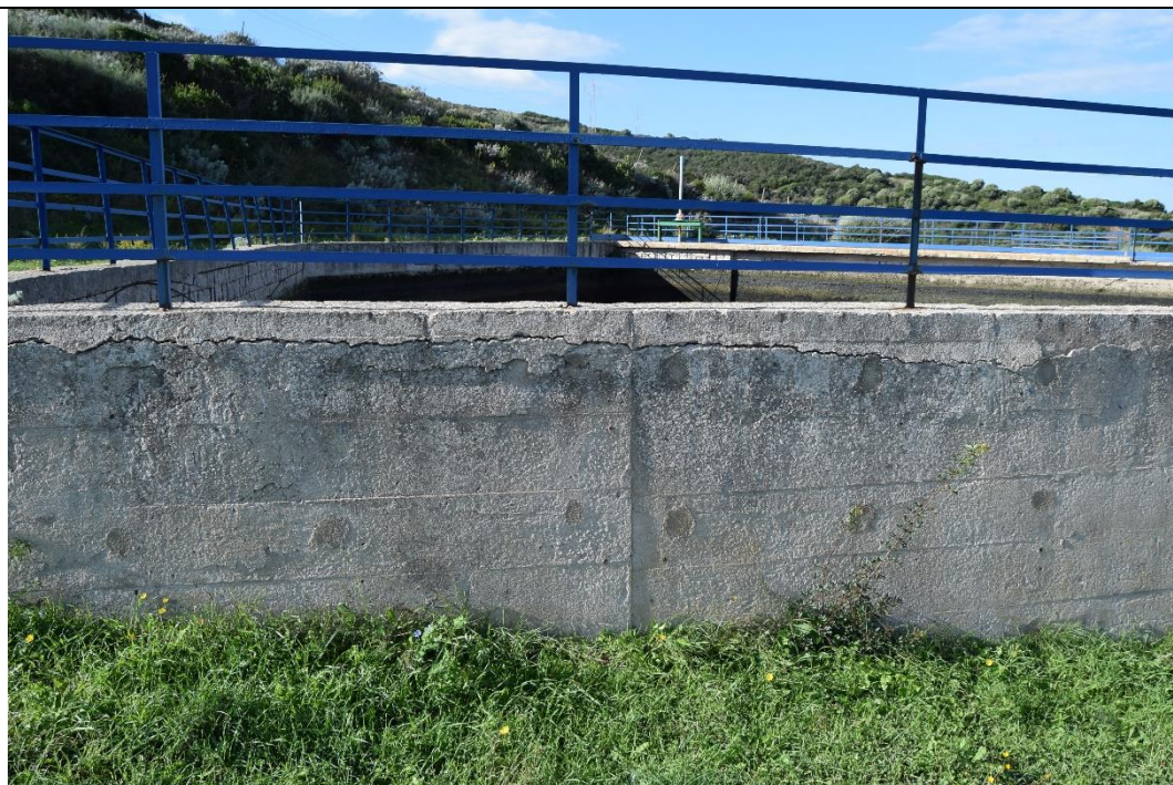
Figura 4-11: paramento perimetrale esterno vasca sx - stato degrado strutture
