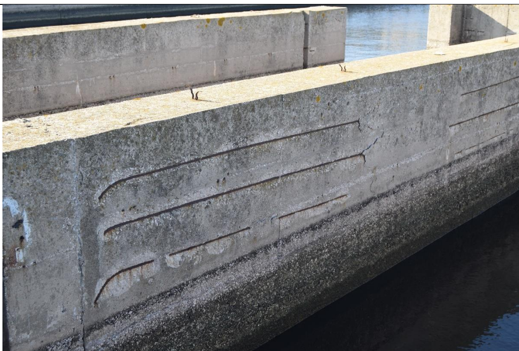
Figura 3-20: Vasca dx - Particolare dello stato di degrado delle strutture del setto ingresso
