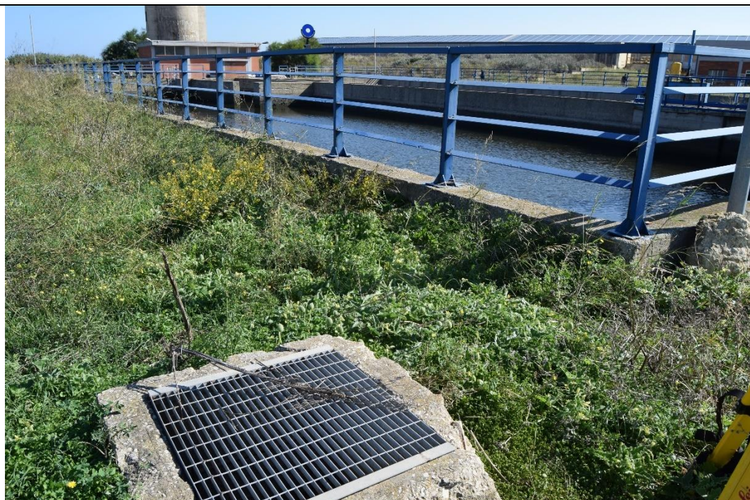
Figura 3-51: Pozzetto di raccolta drenaggi
