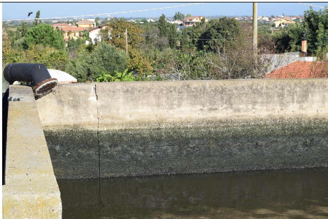
Figura 5-19: Vasca dx - stato di degrado del calcestruzzo del paramento interno
