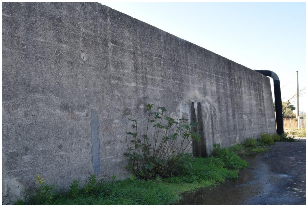
Figura 5-13: Vasca dx - perdita di acqua
