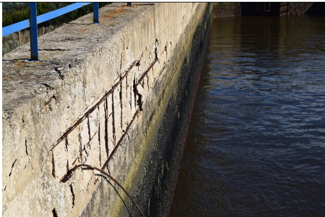
Figura 4-5: Paramento perimetrale vasca dx - stato di degrado delle strutture
