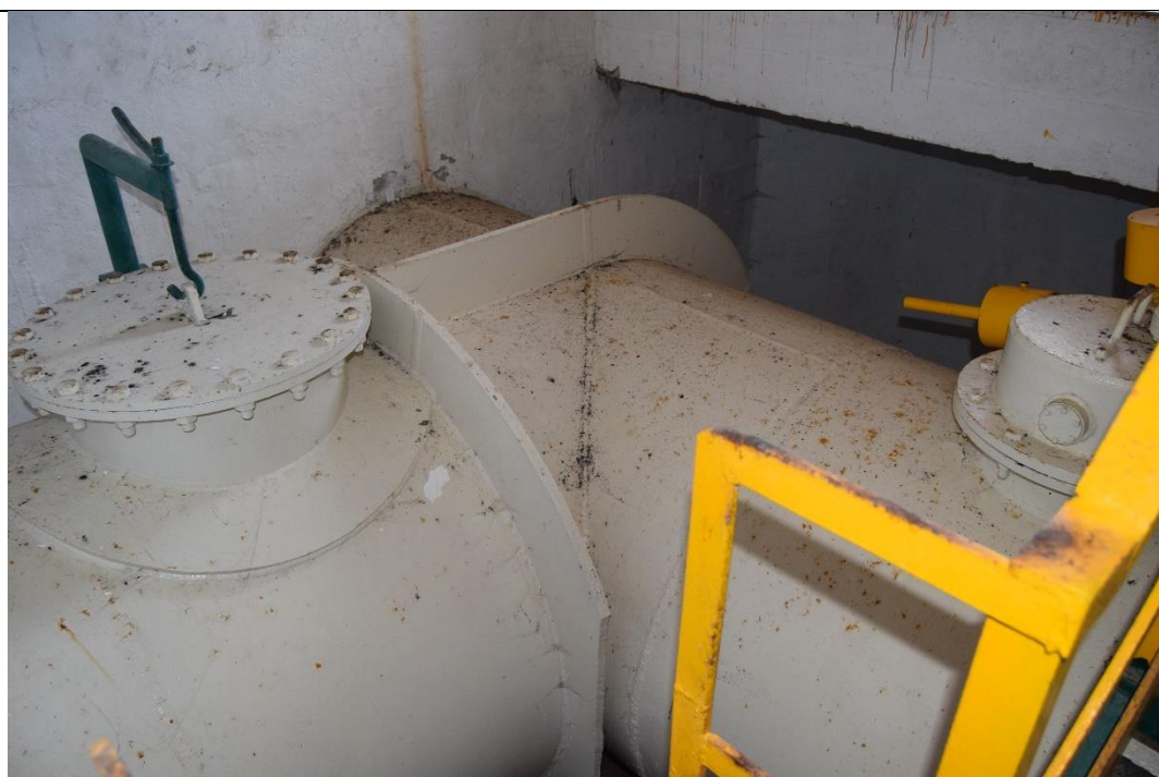
Figura 4-22: camera di manovra- piping by-pass
