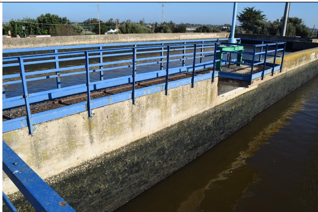
Figura 5-33: vasca di sx: stato di degrado del calcestruzzo del setto divisorio
