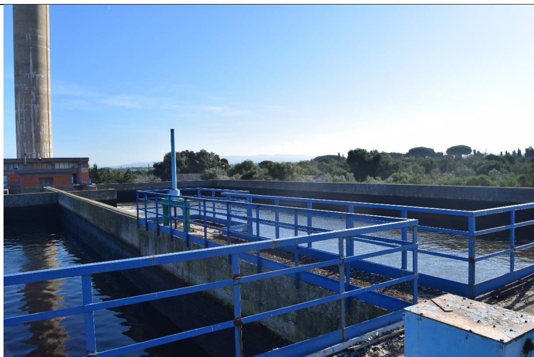
Figura 5-24: Setto divisorio e paratoia da sostituire
