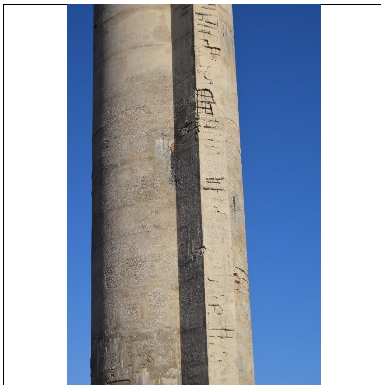
Figura 3-43: Torrino piezometrico - stato di degrado delle strutture
