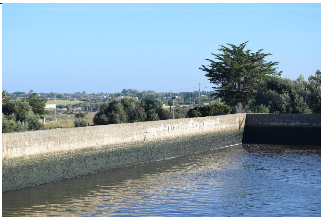
Figura 5-20: Vasca dx - stato di degrado del calcestruzzo del paramento interno
