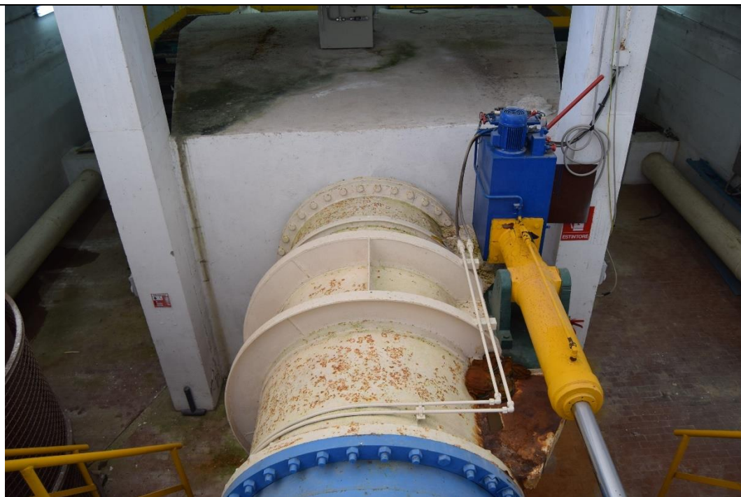
Figura 3-61: Camera manovra: tubazione ingresso DN1400
