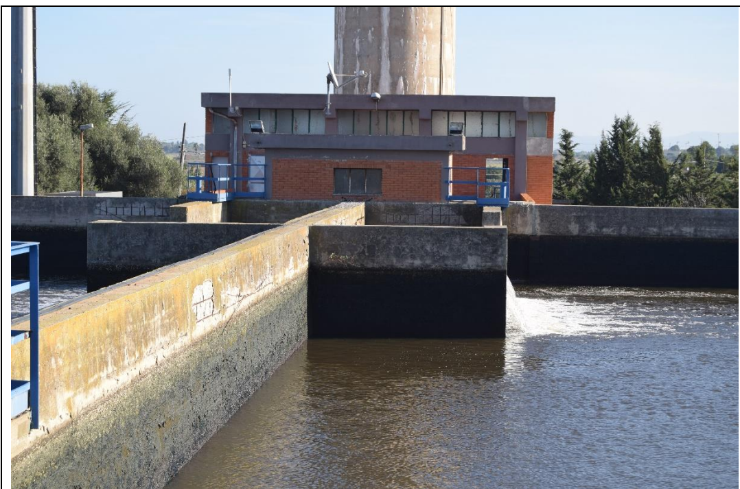
Figura 5-31: vasca di sx: stato di degrado del calcestruzzo del paramento interno
