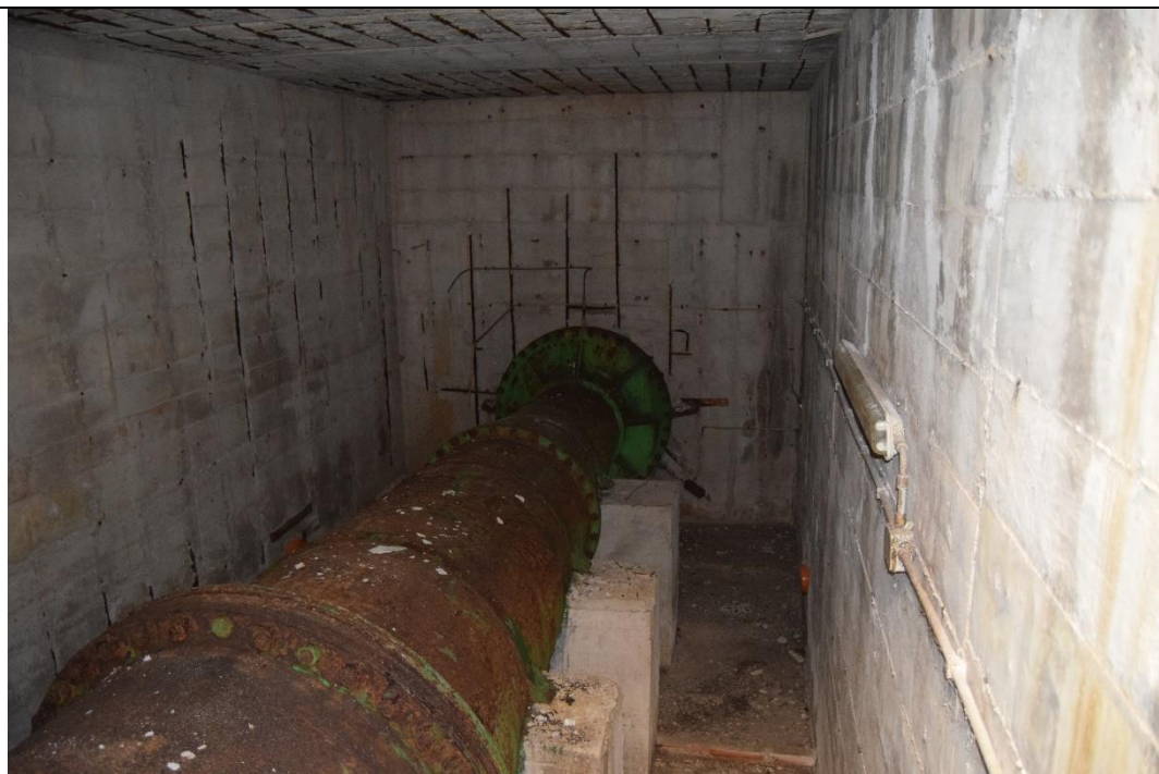
Figura 5-39: camera misuratore di portata in ingresso - stato di degrado del calcestruzzo
