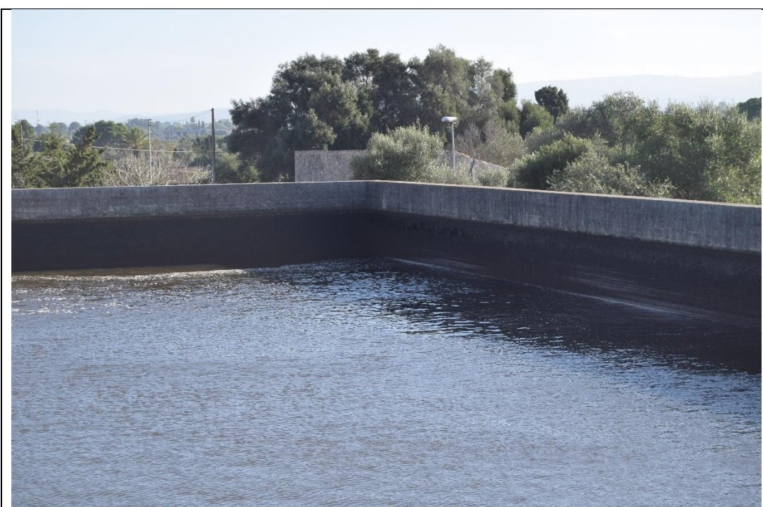
Figura 5-30: vasca di sx: stato di degrado del calcestruzzo del paramento interno
