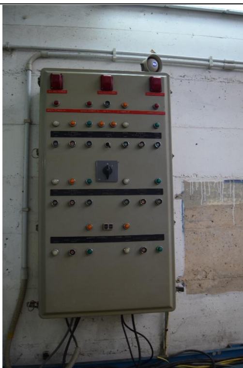
Figura 3-64: Camera manovra: quadro elettrico
