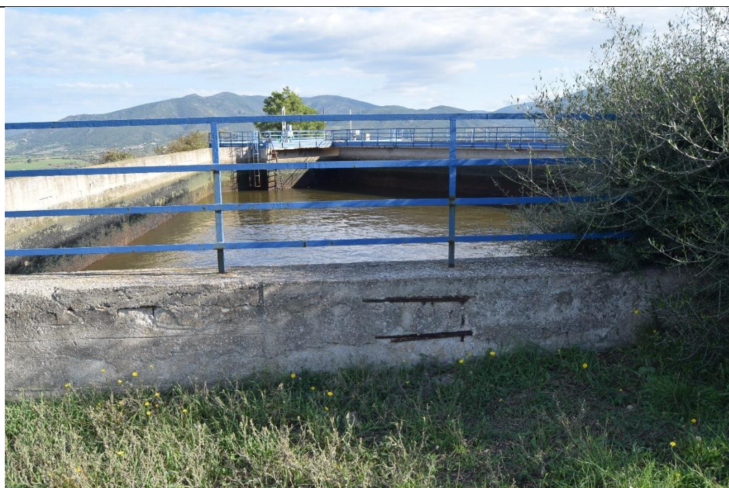
Figura 4-6: Paramento perimetrale vasca dx - stato di degrado delle strutture
