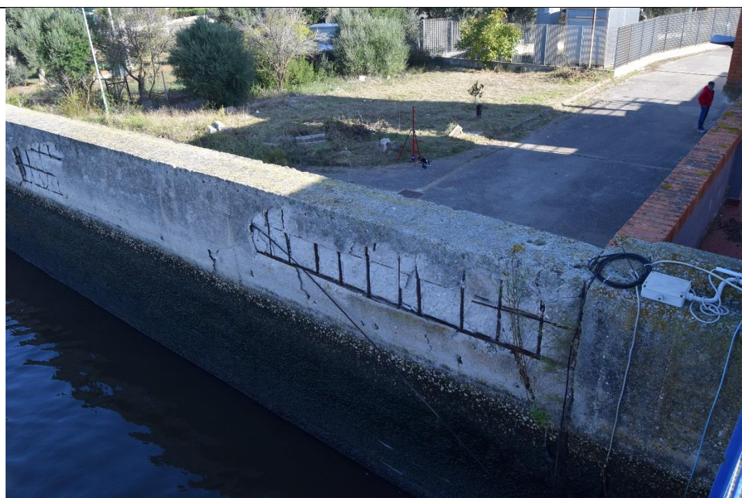
Figura 5-34: vasca di sx: stato di degrado del calcestruzzo del paramento perimetrale
