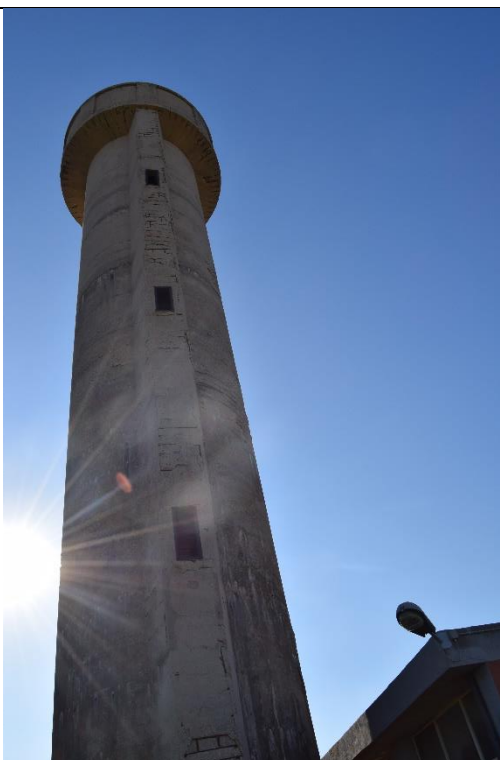
Figura 3-46: Torrino piezometrico - stato di degrado delle strutture
