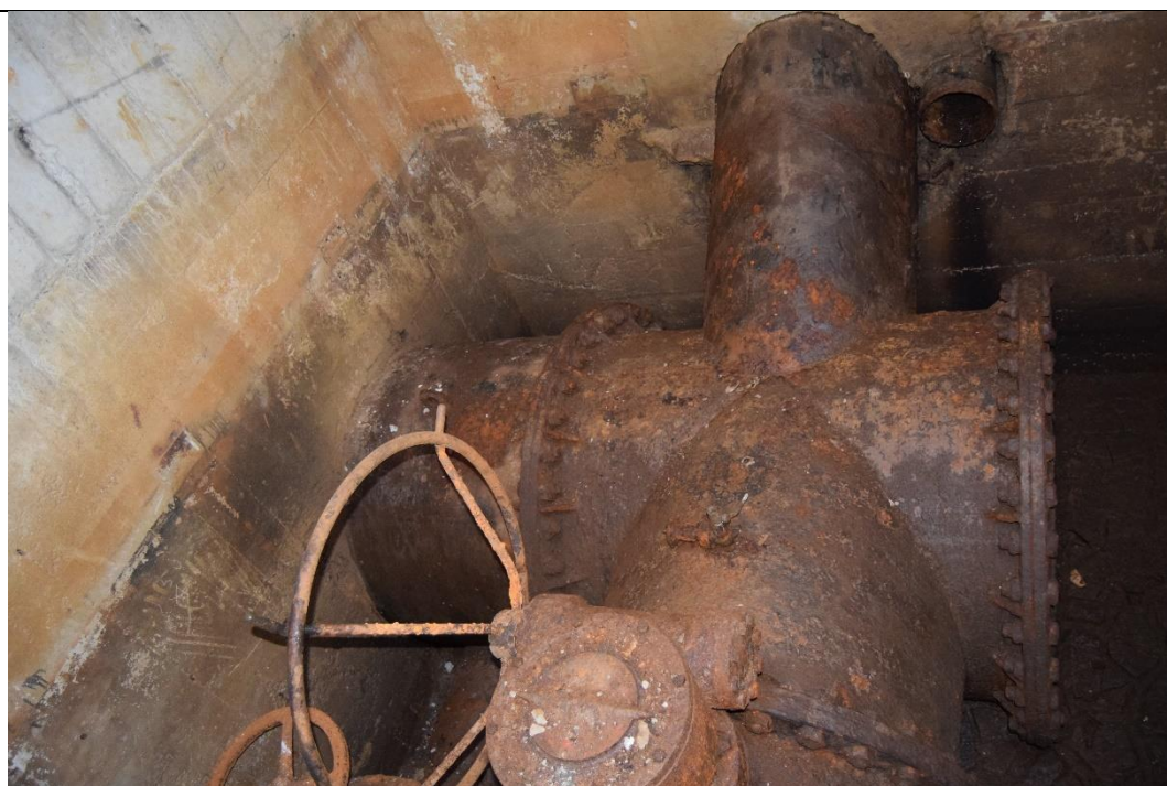
Figura 3-54: Interno camera partizione - stato di degrado del piping
