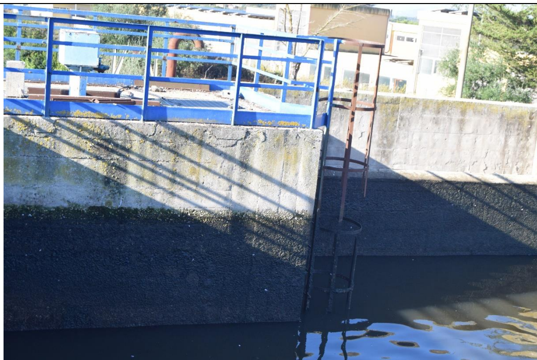
Figura 5-23: vasca di dx: stato di degrado del calcestruzzo in corrispondenza dello sfioro
