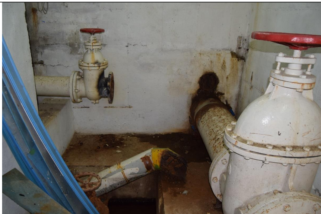
Figura 3-65: Camera manovra: stato di degrado del piping
