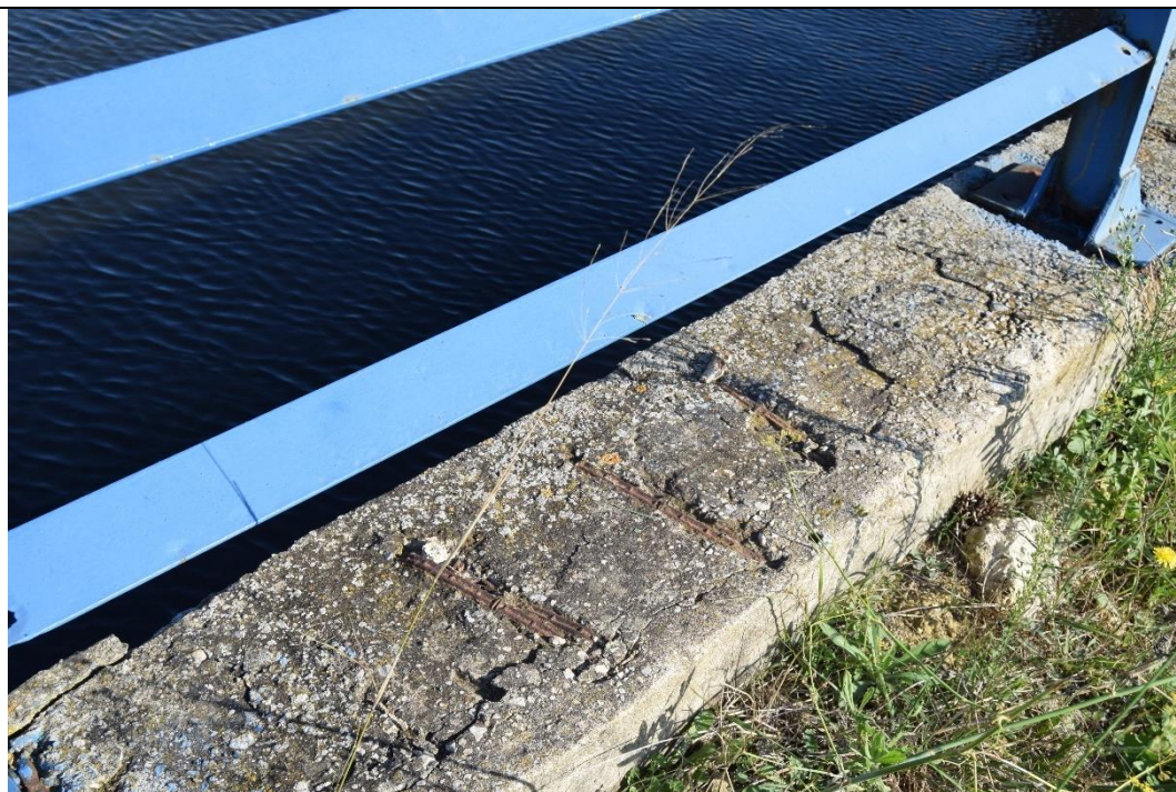
Figura 3-5: Vasca sx stato di degrado delle strutture della parete perimetrale (stafte di armatura)
