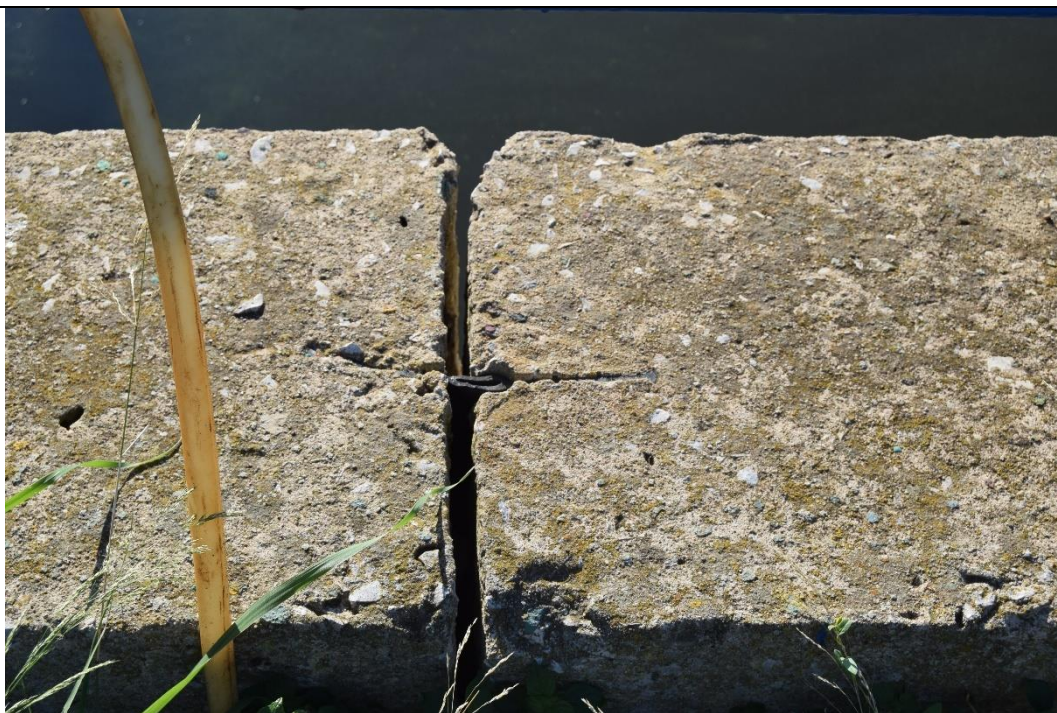
Figura 3-23: Vasca dx - Particolare dello stato di degrado dei giunti del muro perimetrale
