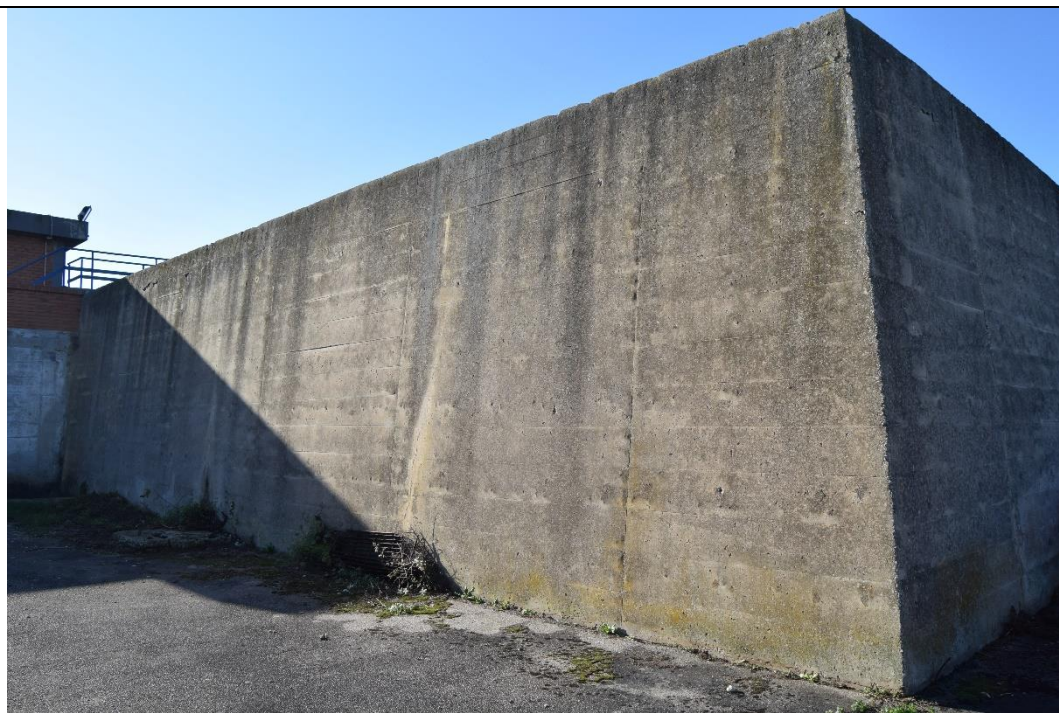
Figura 5-9: Vasca dx: stato di degrado del calcestruzzo esterno
