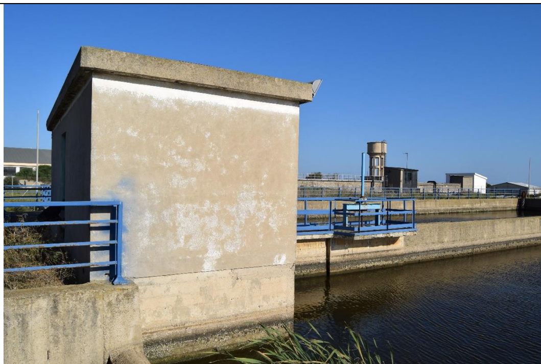
Figura 3-33: Manufatto di presa-stato di degrado del calcestruzzo sul prospetto lato vasca sx
