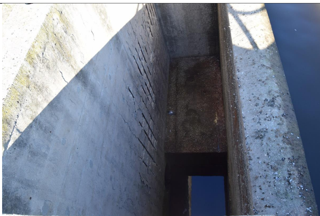
Figura 5-18: Vasca dx - stato di degrado del calcestruzzo dello sfioro
