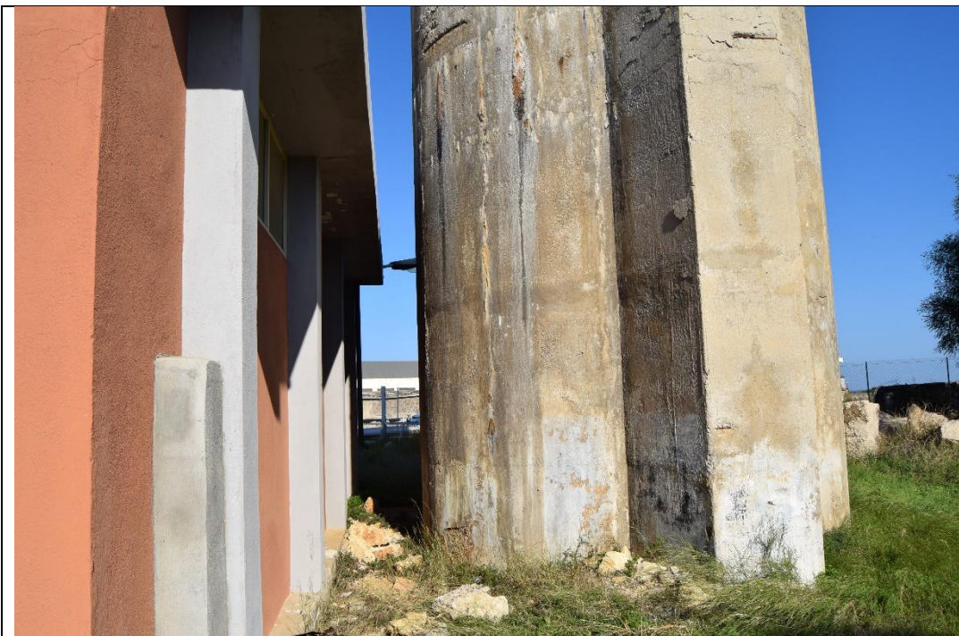
Figura 3-47: Torrino piezometrico - stato di degrado delle strutture
