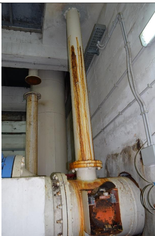
Figura 3-68: Camera manovra: stato di degrado del piping
