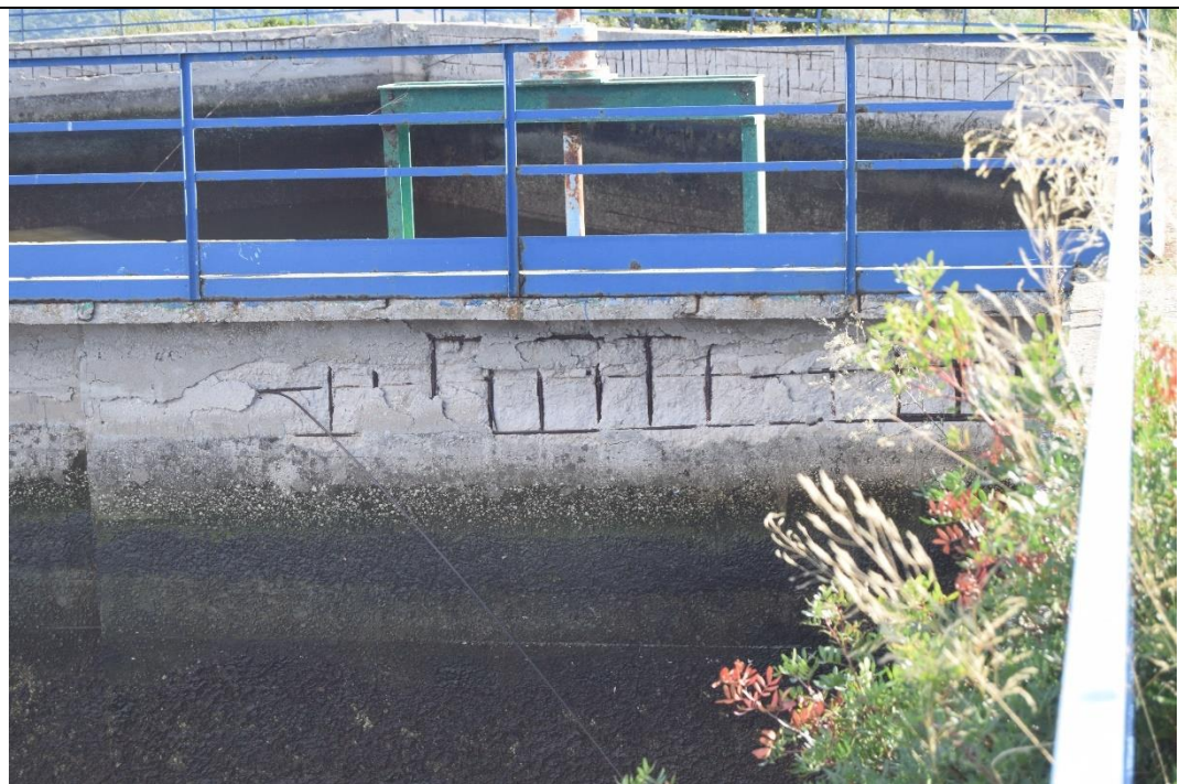
Figura 4-7: setto divisorio tra le vasche - stato degrado struttura
