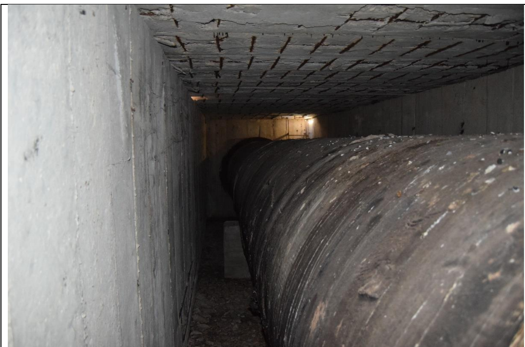
Figura 5-2: Cunicolo da demolire e tubazione da sostituire
