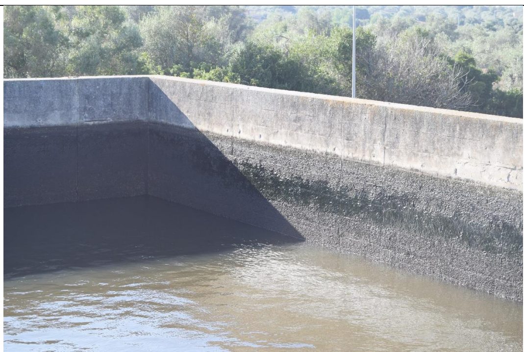
Figura 5-28: vasca di sx: stato di degrado del calcestruzzo del paramento interno
