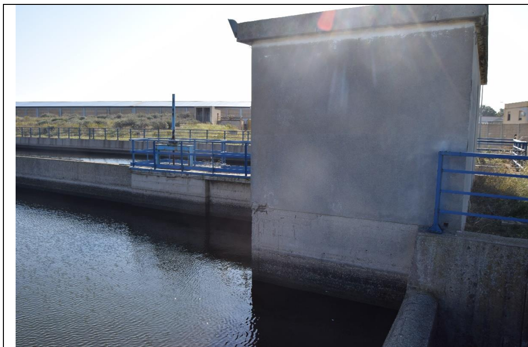
Figura 3-32: Manufatto di presa-stato di degrado del calcestruzzo sul prospetto lato vasca dx
