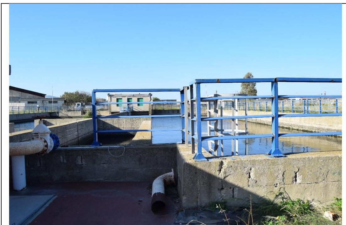
Figura 3-18: Vasca dx - stato di degrado delle strutture del setto perimetrale
