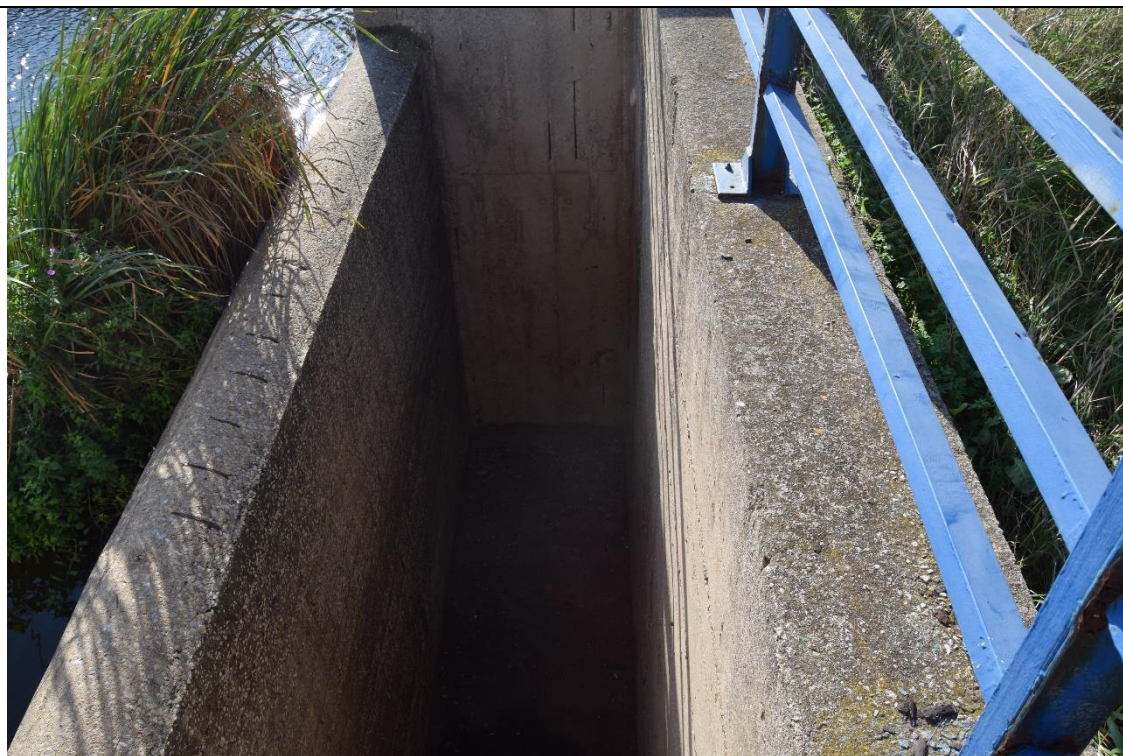
Figura 3-31: Vasca sx- soglia di sfioro in uscita- stato di degrado delle strutture
