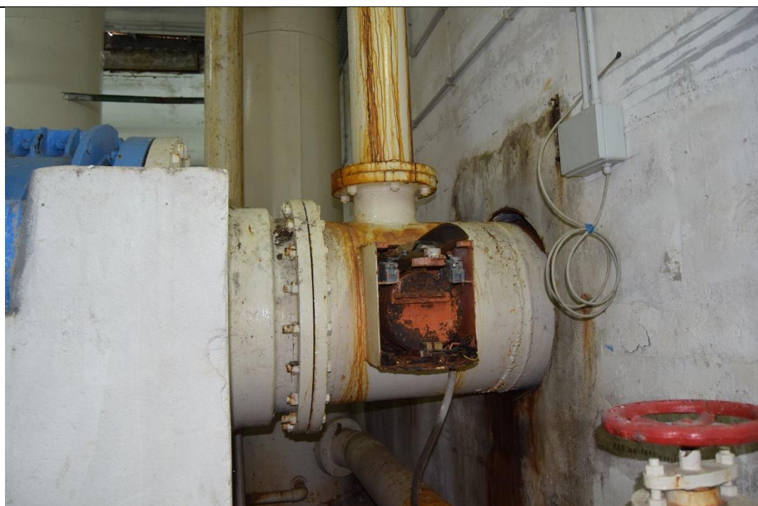
Figura 3-66: Camera manovra: stato di degrado del piping
