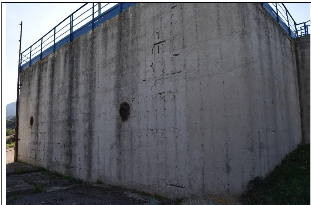
Figura 4-3: Paramento esterno ingresso - stato di degrado delle strutture
