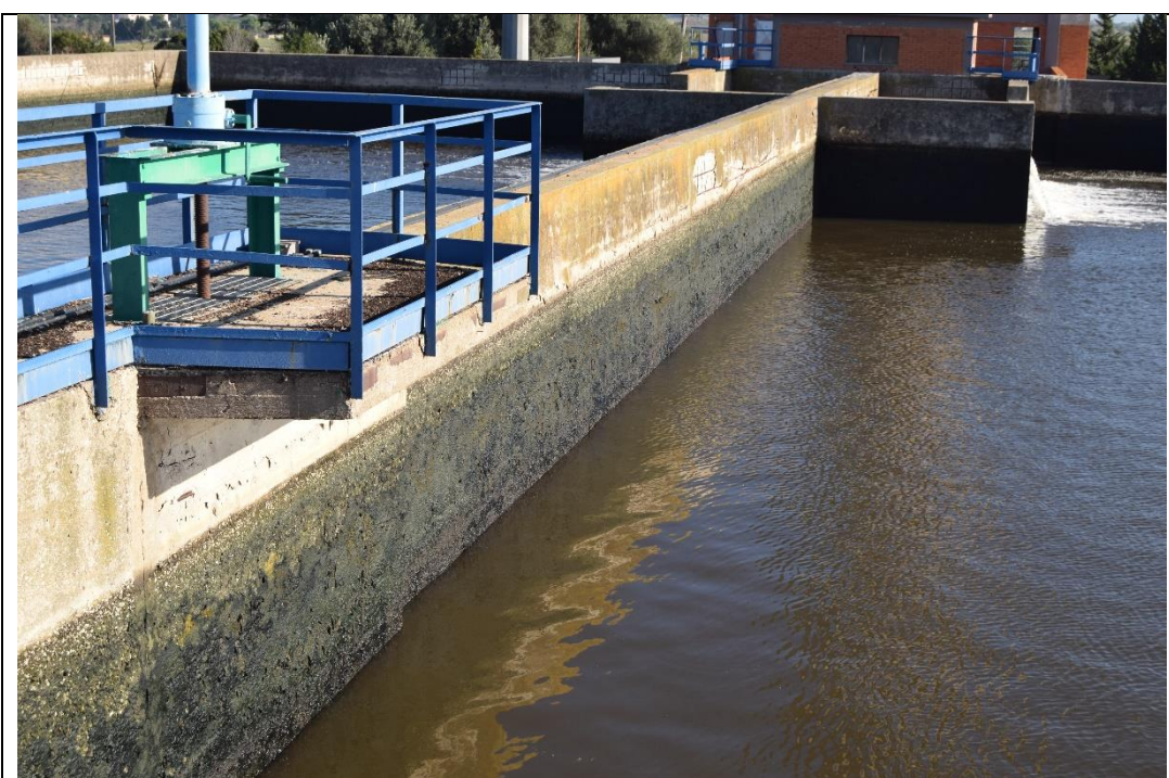
Figura 5-32: vasca di sx: stato di degrado del calcestruzzo del setto divisorio
