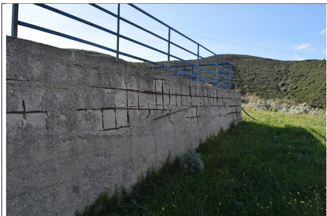
Figura 4-4: Paramento esterno vasca dx - stato di degrado delle strutture
