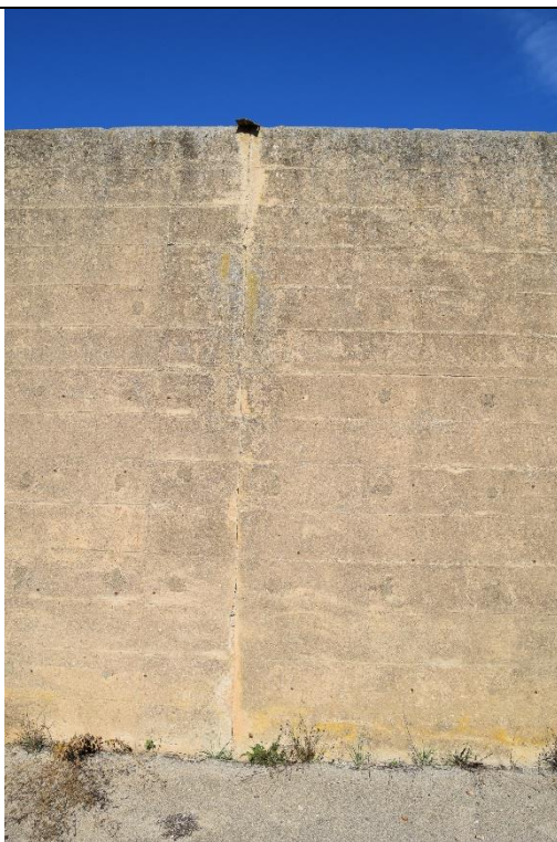
Figura 5-15: Paramento esterno - stato dei giunti
