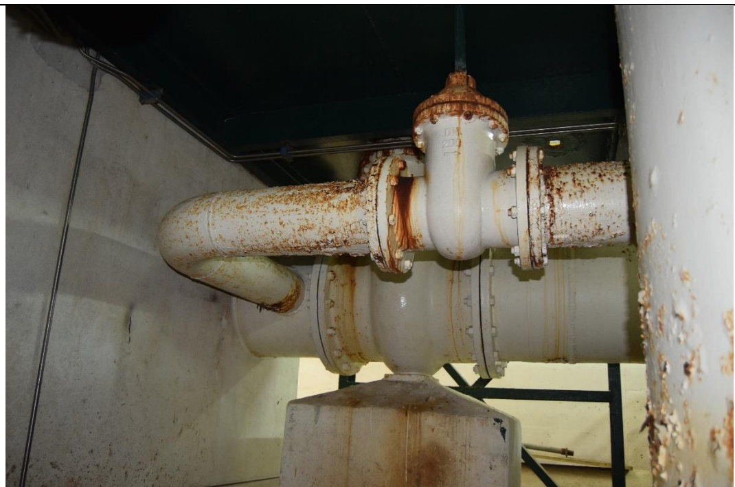
Figura 3-69: Camera manovra: stato di degrado del piping
