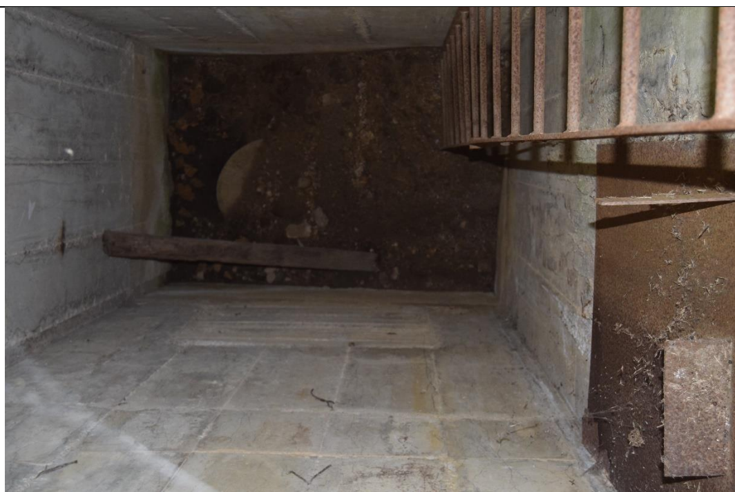
Figura 3-52: Pozzetto di raccolta drenaggi- interno
