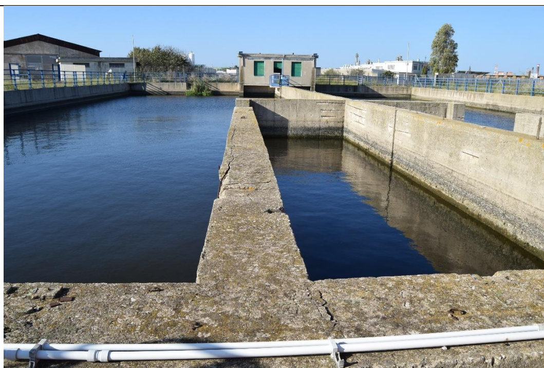
Figura 3-10: Vasca sx - stato di degrado delle strutture del setto ingresso
