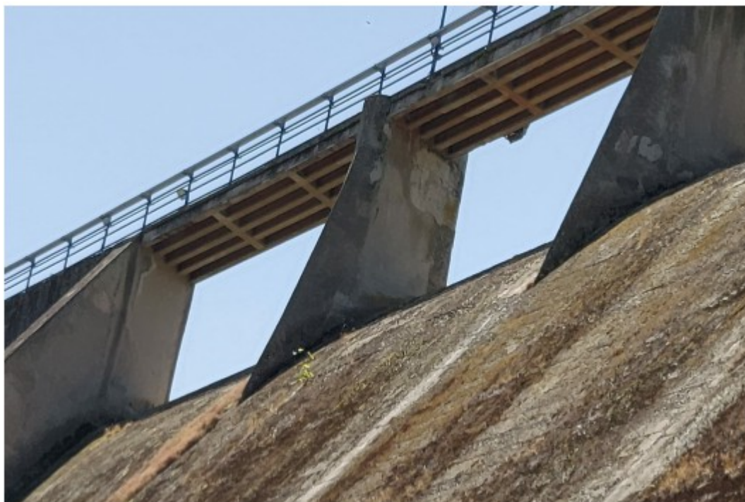
Dettaglio della soglia di sfioro e delle pile
