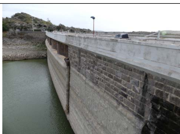
Sifone Sardamag lato invaso (da tagliare in corrispondenza dell'apice)
