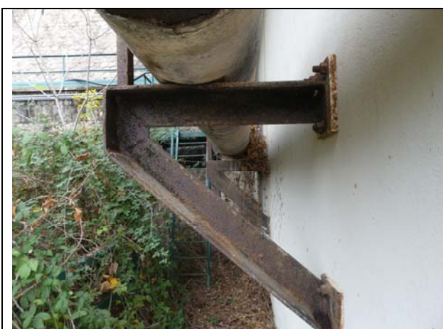
Sifone Sardamag – Dettaglio appoggio parete camera di manovra
