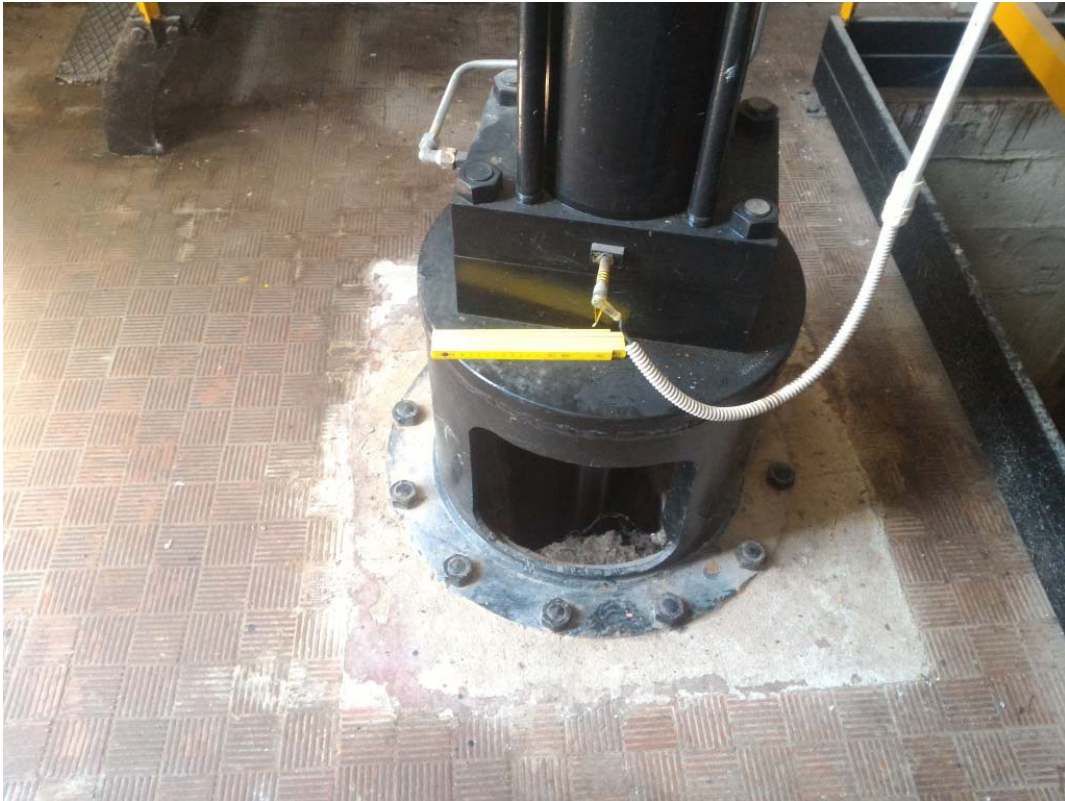
Base del cilindro oleodinamico di manovra, pavimento del vano della torre a quota coronamento
