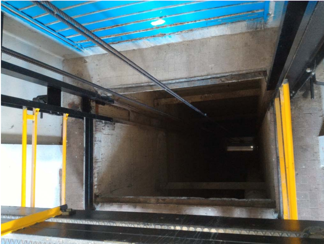
Gargami e fune di manovra della griglia a sacco, vista dalla botola della torre a quota coronamento (dimensioni 2,00 x 0,85 m)
