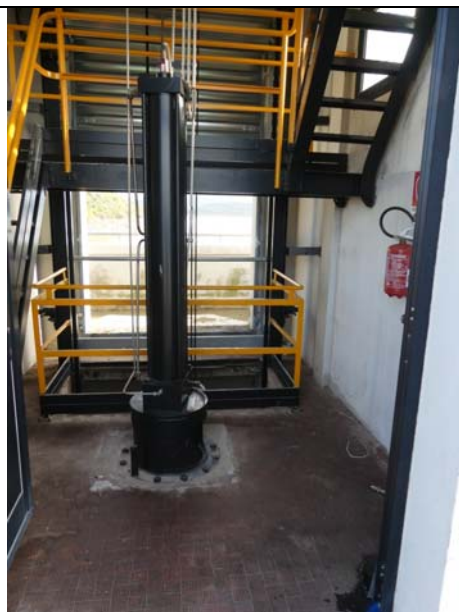
Cabina di accesso – Vista dall'entrata (cilindro paratoia e parapetto botola griglia a sacco)
