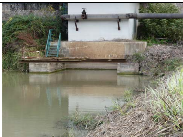
Scarico di fondo – Rigurgito dell’uscita del dissipatore per effetto della briglia-guado a valle
