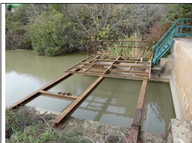
Scarico di fondo – Uscita dal dissipatore – Carpenteria metallica dimessa (da smantellare ed allontanare)
