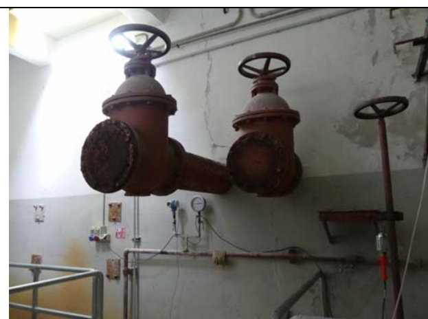
Camera manovra – Vano inferiore – Parete destra – Apparecchiature dimesse (da rimuovere ed allontanare)
