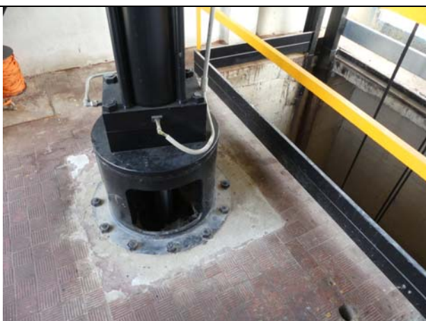
Dettaglio attacco cilindro a pavimento
