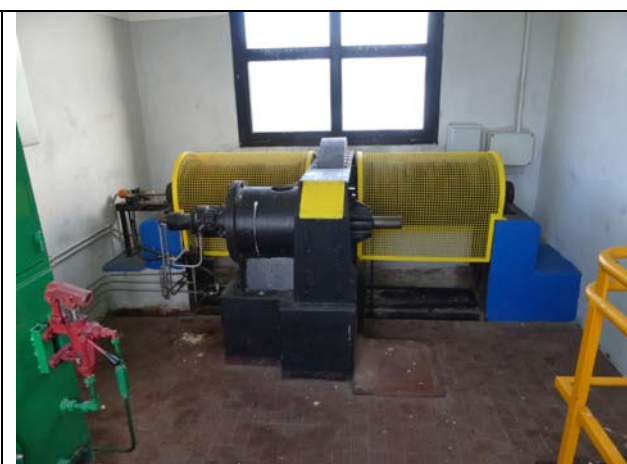
Cabina di accesso - Vano superiore – Argano sollevamento griglia a sacco
