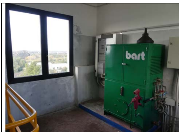
Cabina di accesso - Vano superiore – Quadro e centrale comando paratoia
