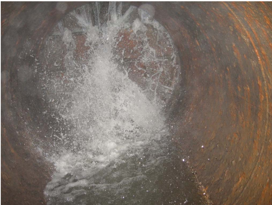
Vista dall'interno della condotta di scarico. E' evidente la mancata tenuta della paratoia
