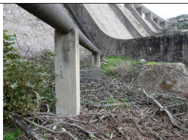
Sifone Sardamag DN400 e pilastri (da demolire ed allontanare) – Vista lungo il piede di valle diga
