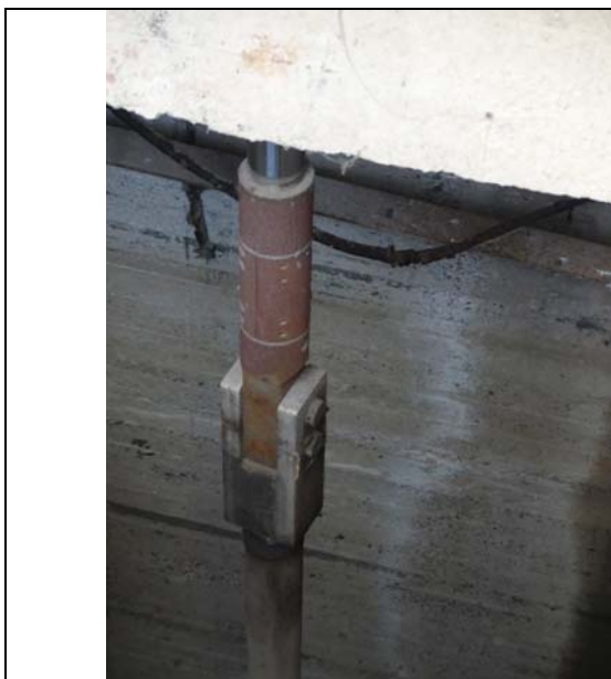
Dettaglio attacco superiore cilindro-asta manovra paratoia
