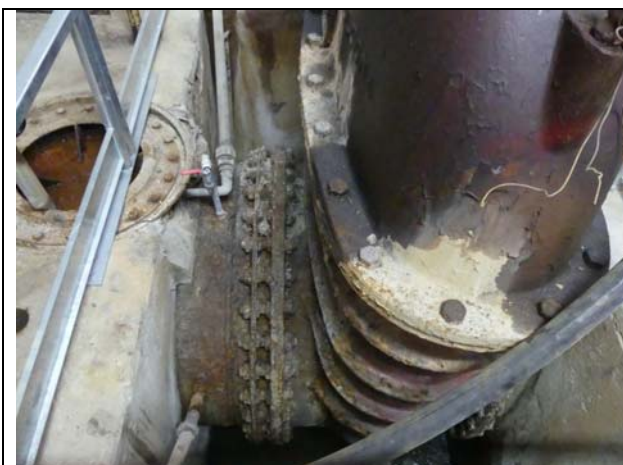
Camera manovra – Vano inferiore – Saracinesca DN1400 e giunto di smontaggio a tre flange
