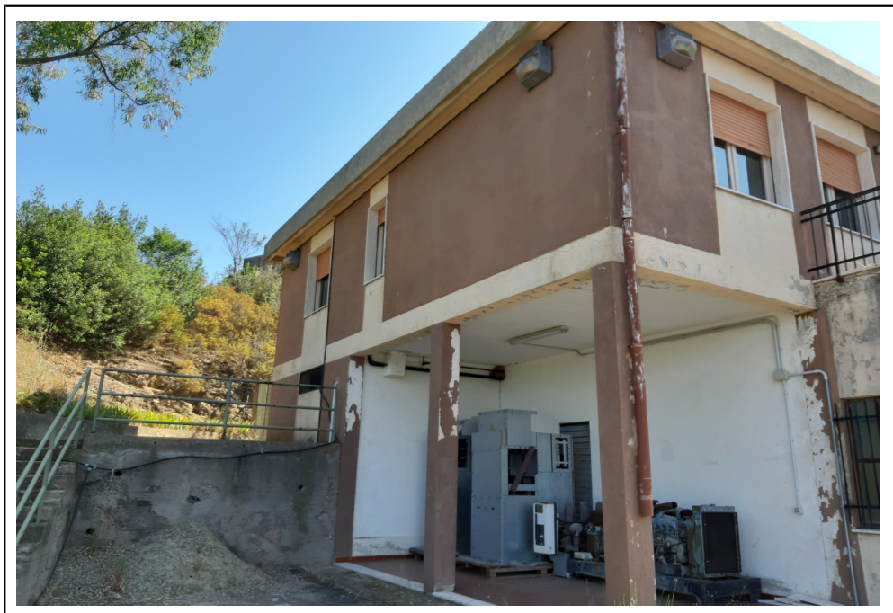
Vista su prospetto lato OVEST lavorazioni sull'intera facciata, infissi, sostituzione di serranda metallica e sua motorizzazione, pluviali, risanamento di calcestruzzo e ferri di armatura, intonaci (30%) e tinteggiature (100%)
