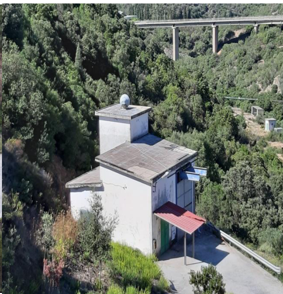
Figura – Edificio sul pozzo dello scarico di fondo, cabina elettrica e locale gruppo elettrogeno
