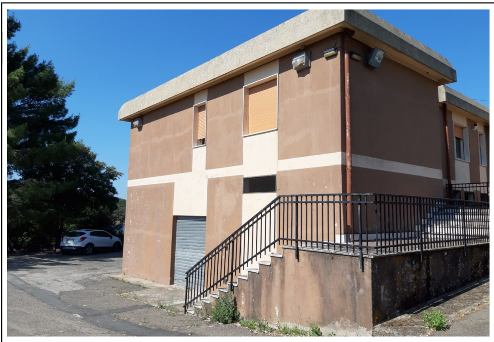
Vista su prospetto lato OVEST lavorazioni sull'intera facciata per scale, ringhiere, infissi, sostituzione di serranda metallica e sua motorizzazione, pluviali, risanamento di calcestruzzo e ferri di armatura, intonaci (30%) e tinteggiature (100%)
