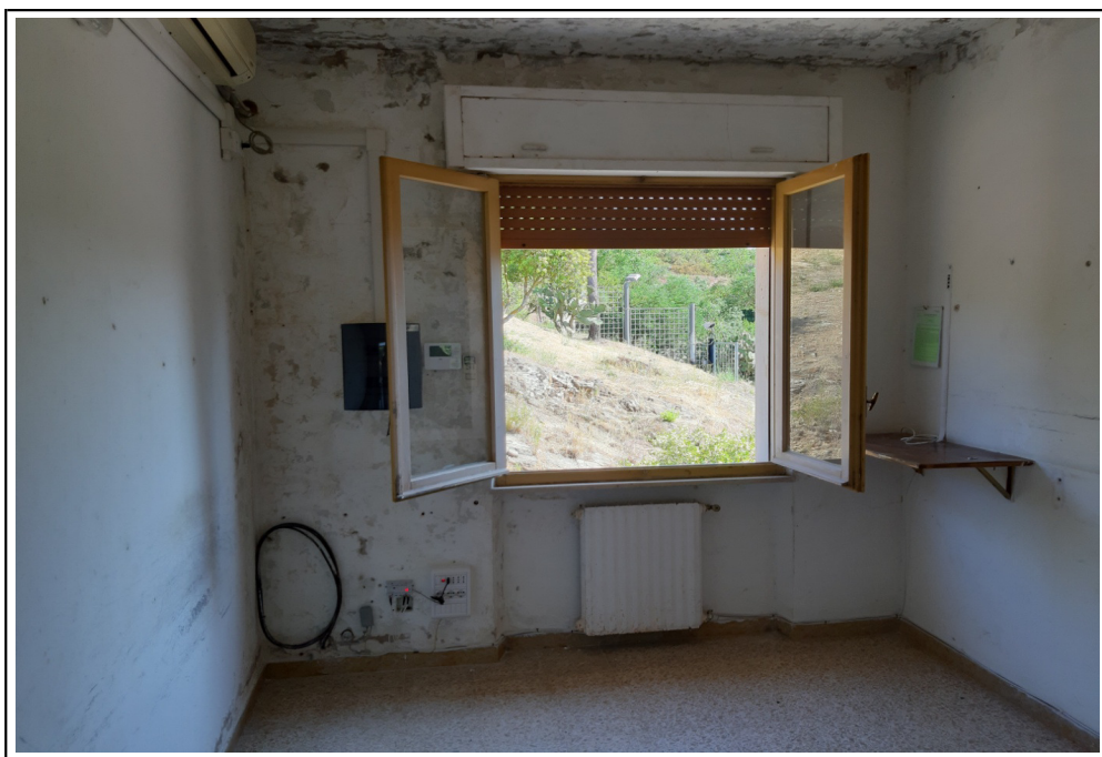
Stanze al Piano Primo Allontanamento corpo scaldante con chiusura definitiva delle tubazioni, sostituzione di infisso esterno, ripristino di intonaco su pareti e soffitto valutabile con circa il 10-15% della superficie, sostituzione di parti di battiscopa, tinteggiatura (100%), lucidatura del pavimento.
