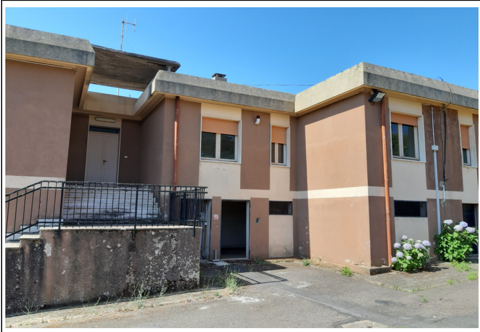
Vista su prospetto lato NORD lavorazioni sull'intera facciata per scale, ringhiere, infissi, pluviali, risanamento di calcestruzzo e ferri di armatura, intonaci (30%) e tinteggiature (100%)
