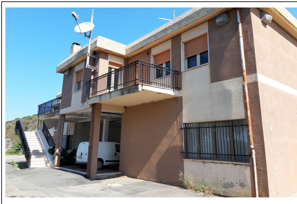
Vista su prospetto lato SUD lavorazioni sull'intera facciata per scale, ringhiere, infissi, pluviali, grate su infissi, risanamento di calcestruzzo e ferri di armatura, intonaci (30%) e tinteggiature (100%)
