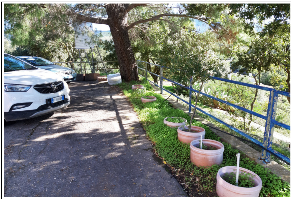
Sistemazione area perimetrale casa di guardia con pavimentazione in bitume e sistemazione di aiuola con cordoli in cls e messa a dimora di terra vegetale e piante arboree
