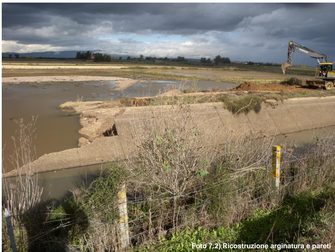
Foto 7.1) Ricostruzione arginatura e pareti
