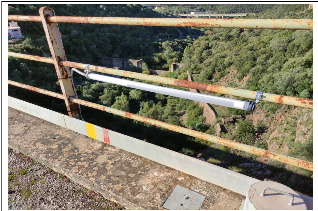
Vista su nuova lampada di recente installazione da smontare durante la fase di allontanamento vecchio parapetto e rimontare sul nuovo, (8 lampade sulla destra e 8 lampade sulla sinistra)
