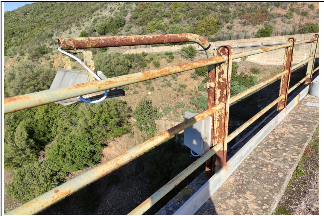
Vecchia struttura porta lampada, da smontare e conferire a discarica
