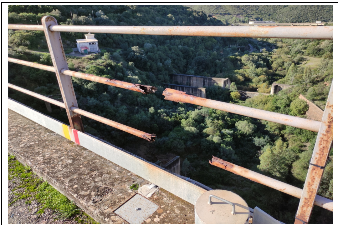
Vista su parapetto con evidenti segni di deterioramento
