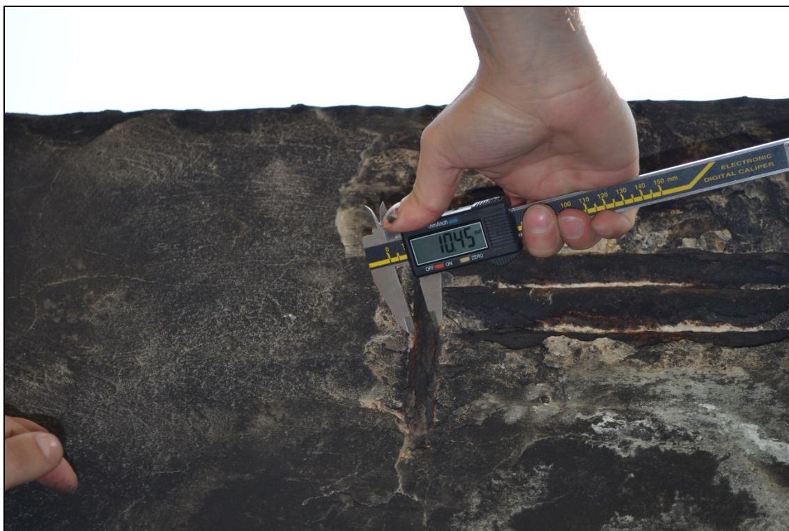
Figura 26 - Ponte Canale Guasila I - Campata Speculare - Misura del Diametro con Calibro Digitale
