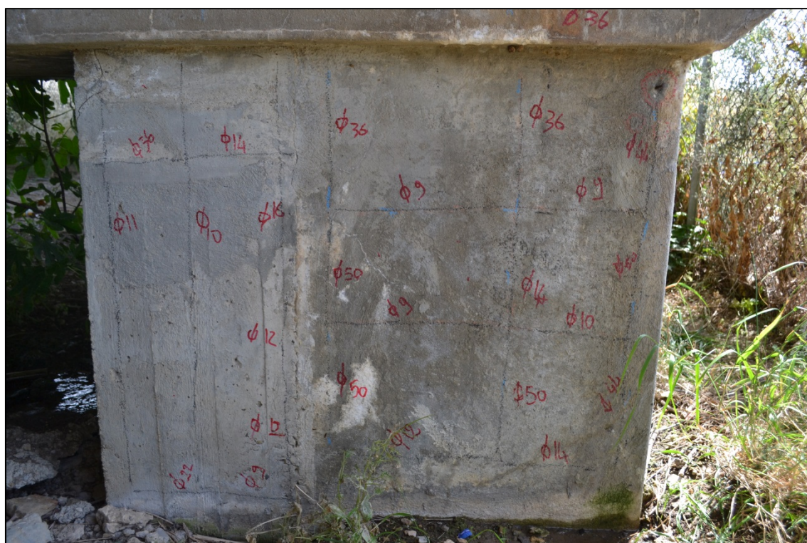
Figura 16 - Ponte Canale Guasila I - Misura del Diametro delle Armature - Pilastro
