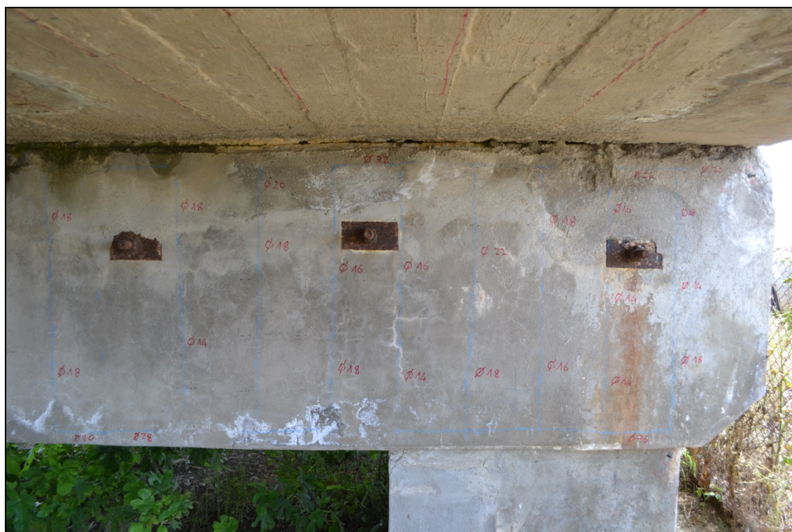
Figura 15 - Ponte Canale Guasila I - Misura del Diametro delle Armature - Trave
