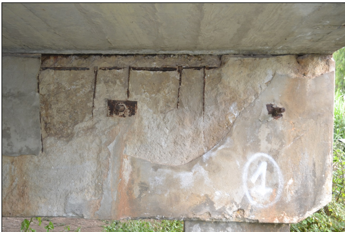
Figura 19 - Ponte Canale Guasila I - Rilievo Diretto del Diametro delle Armature - Trave
