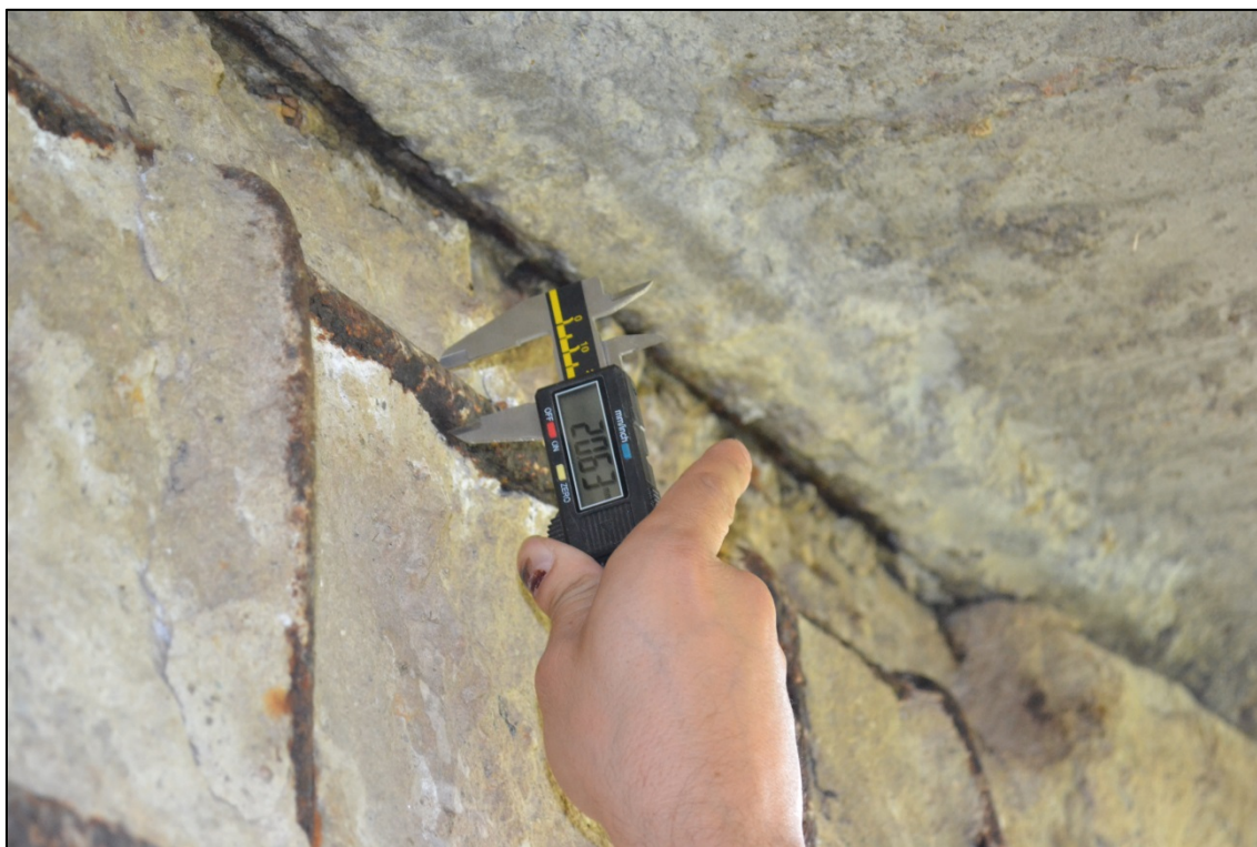
Figura 23 - Ponte Canale Guasila I - Rilievo Diretto del Diametro delle Armature - Trave - Armature Orizzontali
