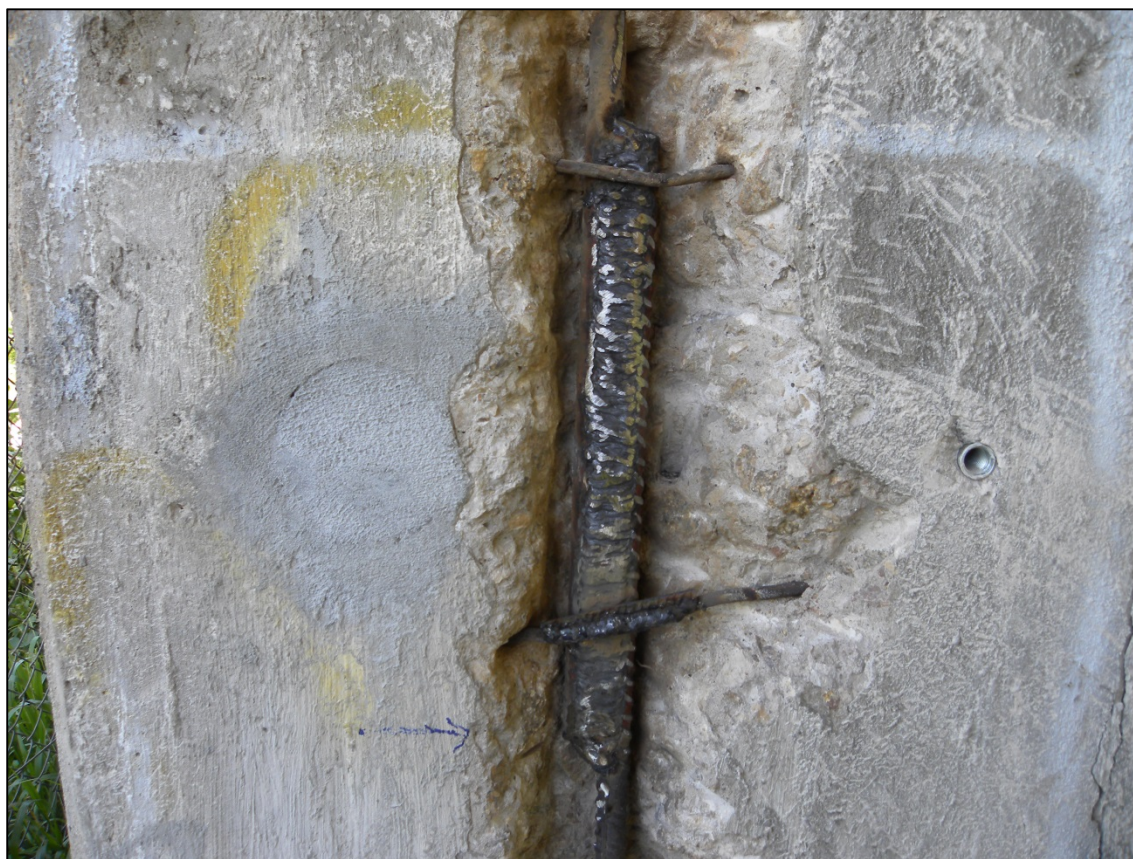
Figura 5 - Immagine del Ripristino delle Barre di Armatura
