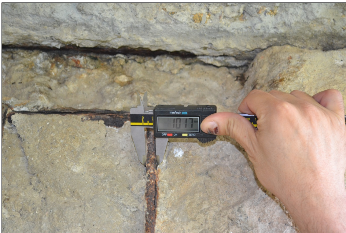
Figura 20 - Ponte Canale Guasila I - Rilievo Diretto del Diametro delle Armature - Trave - Armature Verticali
