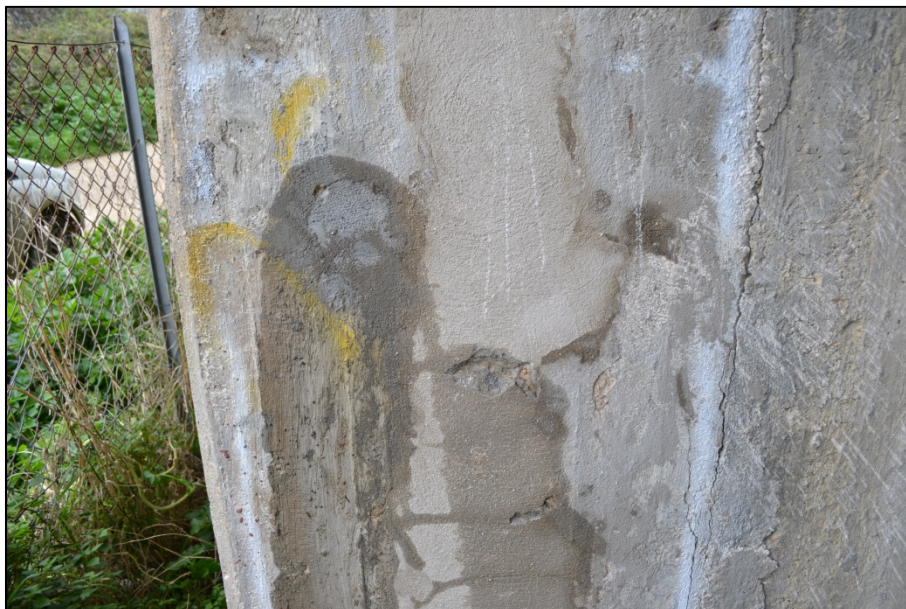
Figura 50 - Sopralluogo di Verifica dei Ripristini del Manufatto. Immagine della Verifica del Ripristino dell' Armatura e del Carotaggio
