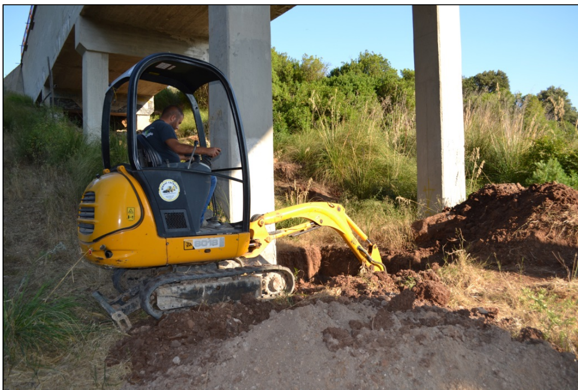
Figura 40 - Immagine della Fase di Scavo per la Messa in Luce delle Fondazioni sul Ponte Canale Segariu
