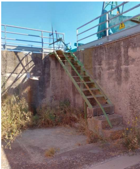
Figura 2 Traversa Monastir Scala in acciaio da sostituire
