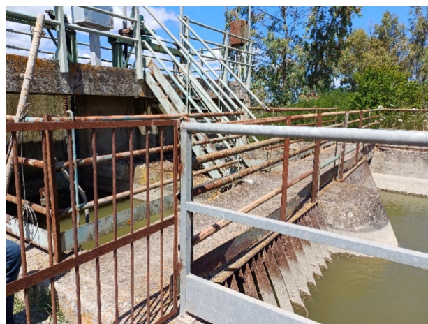
Figura 6 Sostituzione parapetti lungo passerella a monte del sifone nei pressi del Sollevamento ONC
