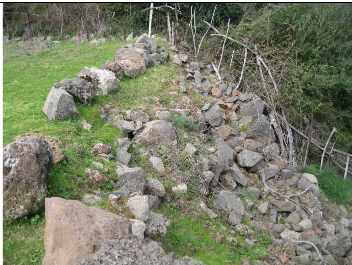
Foto 18 Sez.135-133 Forte erosione della sede stradale per rottura muro di sottoscarpa a secco che è da ricostruire. Consigliato lo spostamento della sede stradale verso l'interno e la realizzazione di una berlinese
