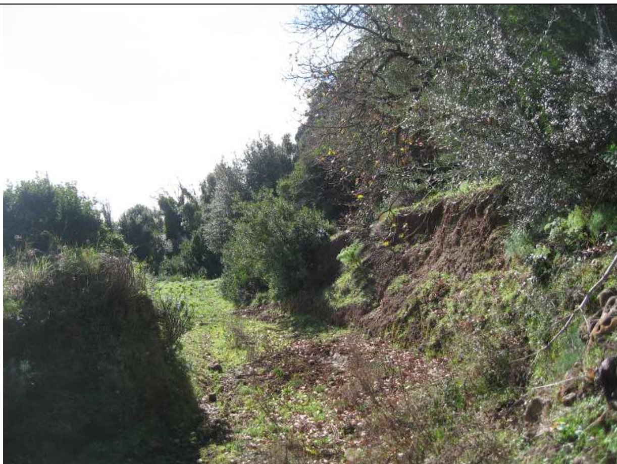
Foto 14. Sez.160-159 Scarpata in detrito di altezza circa 3,0 m, necessità di realizzare un muro di sostegno in cls
