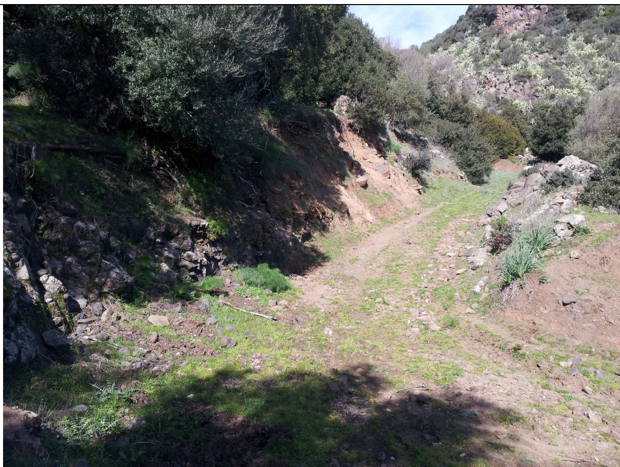
Foto 8 Sez.207 Fronte scavo subverticale lato monte in basalto, e quindi in detrito dopo circa 5-6 m dalla curva che va sostenuto con un muro di sostegno di altezza circa 2,50 m per un tratto lungo circa 20 m.
