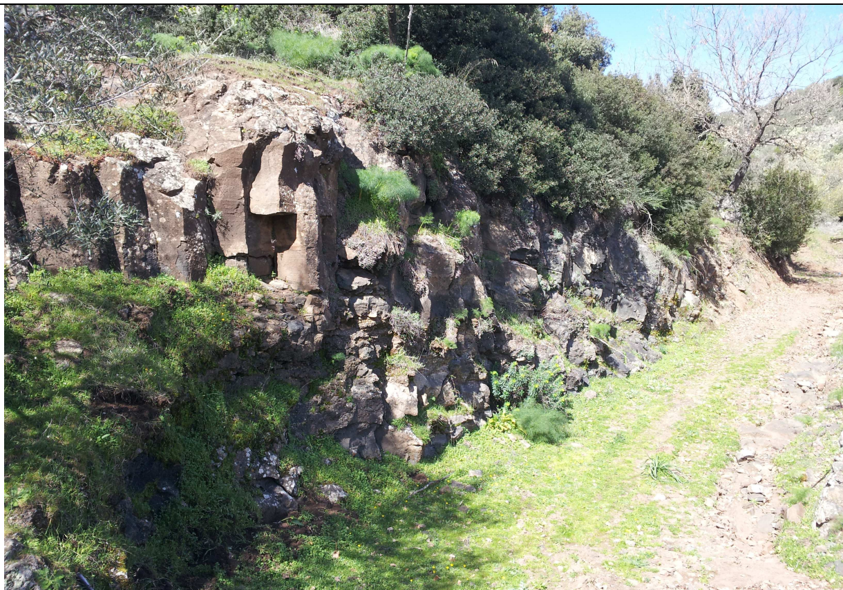
Foto 7 Sez. 209 Fronte scavo subverticale lato monte in basalto,
