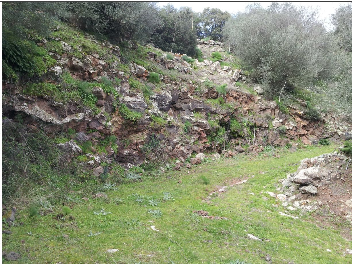
Foto 23 Sez.116 Fronte scavo in basalto da bonificare
