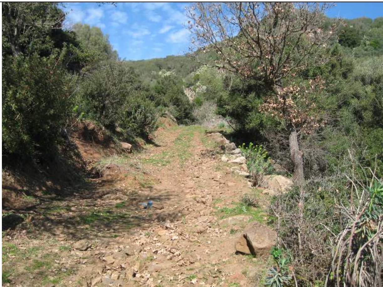
Foto 13 Sez.169-165 Scarpata in detrito di altezza limitata, è sufficiente la riprofilatura
