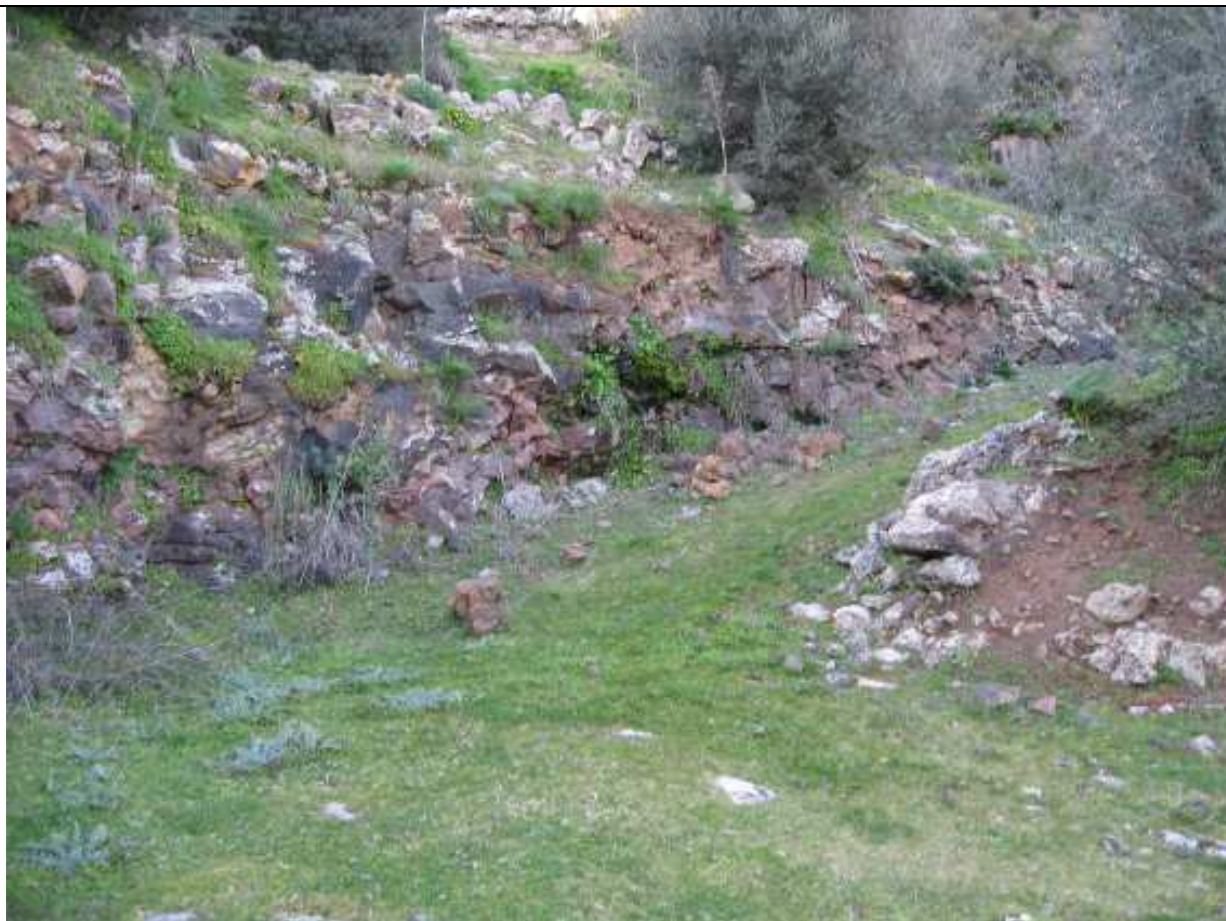
Foto 25 Sez 102-101 Fronte scavo in basalto da bonificare
