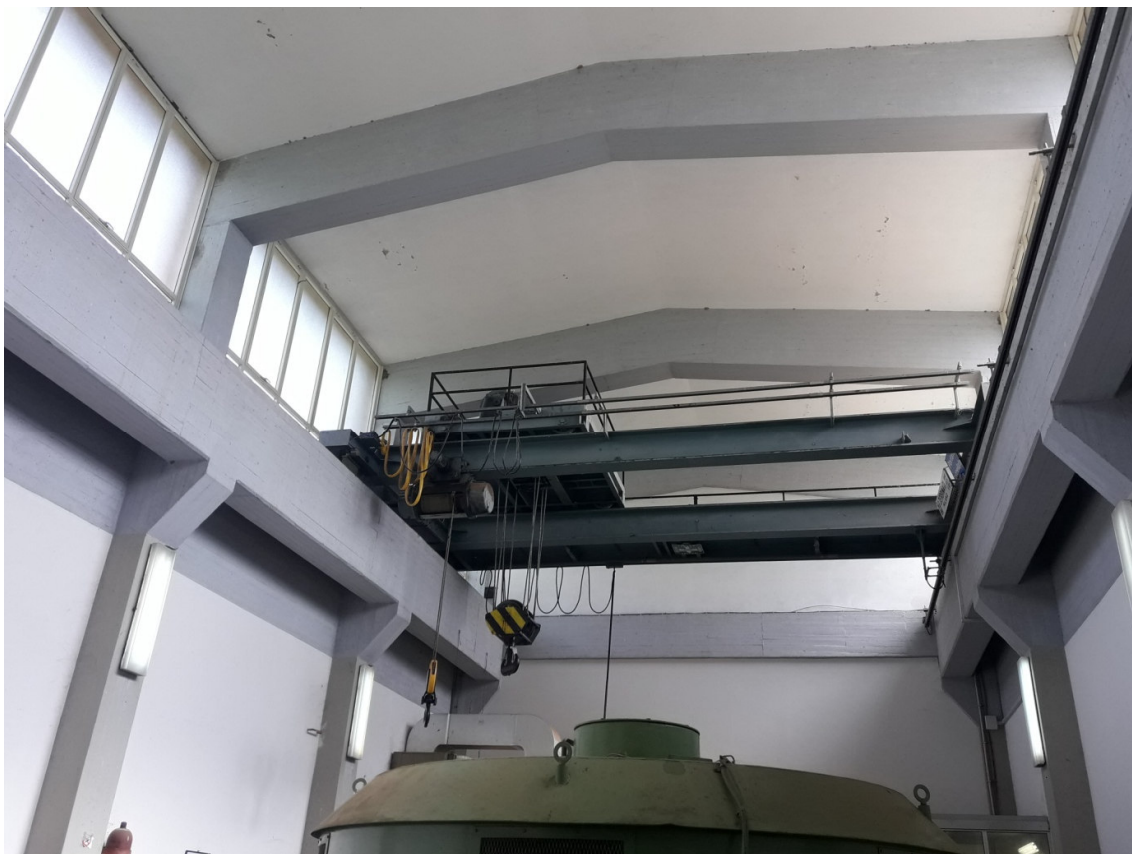
Figura 13 – Sistema carroponete "Zerbinati Milano" disponibile per le lavorazioni di sostituzione Lotto 1B.
