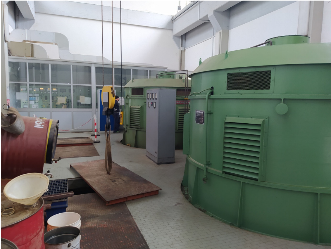
Figura 3 – motori elettrici Savignano EP1/EP2 4.400 kW da sostituire "lotto 1B"
