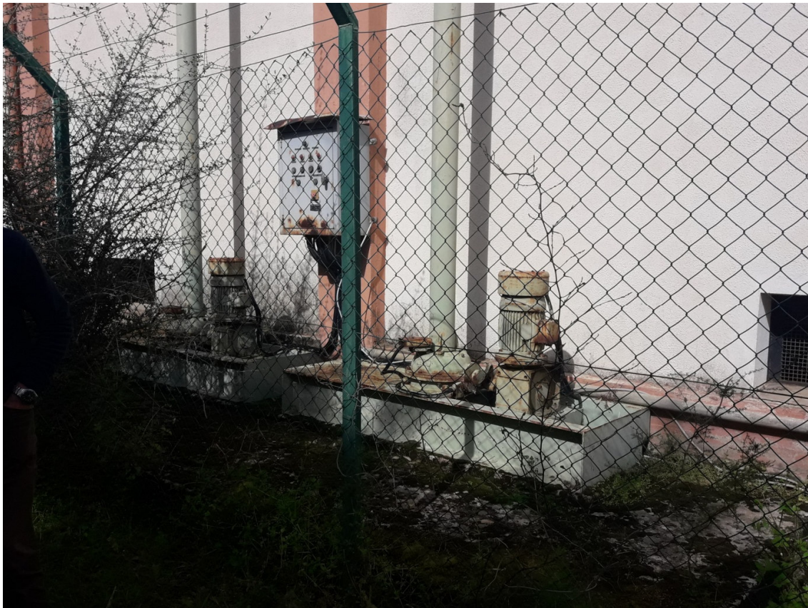
Figura 14 – Sistema paratoie intercettazione vasche è previsto il ripristino funzionale con altro intervento.
