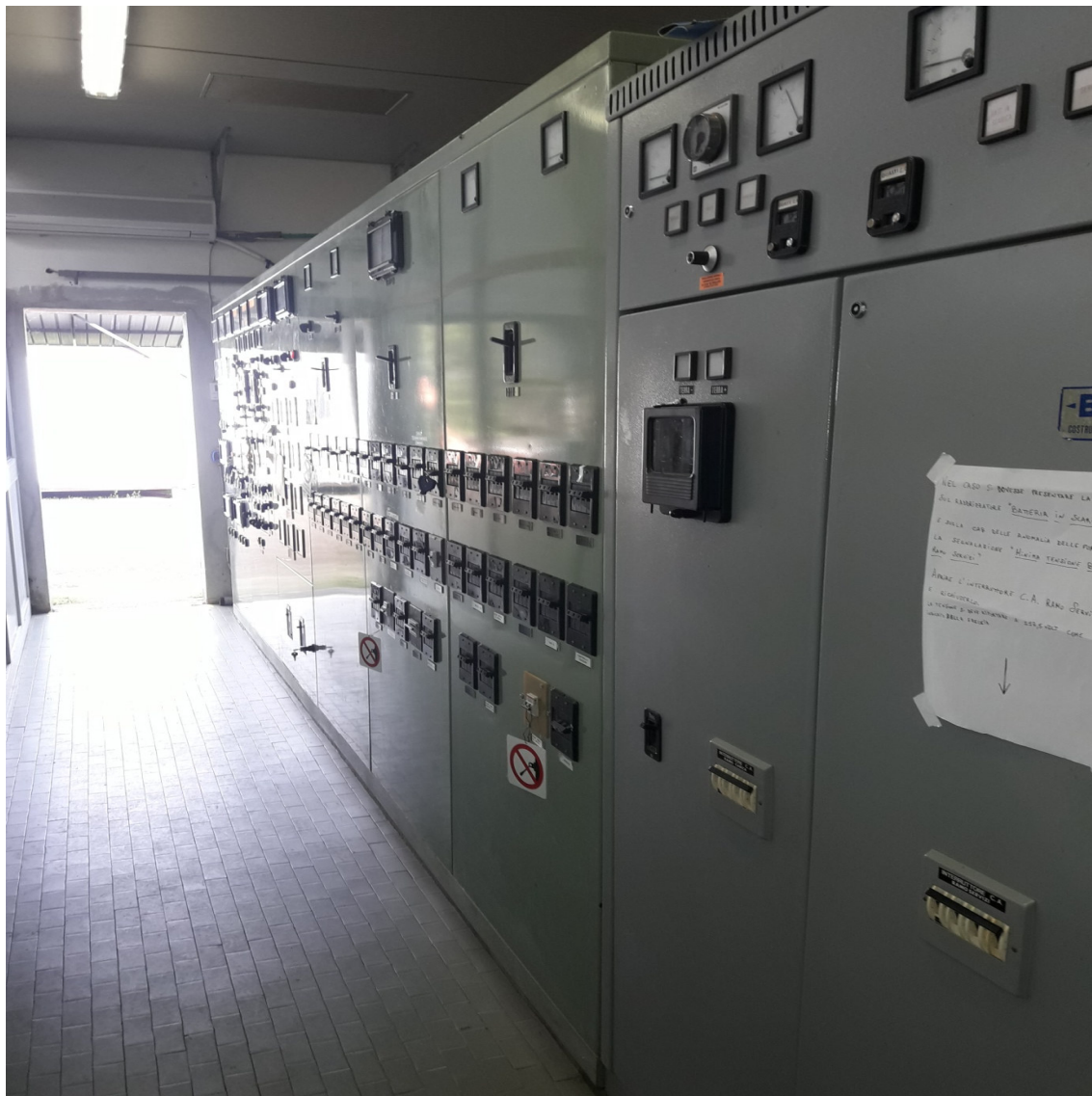
Figura 7– Quadro protezioni avviamento elettropompe EP1/EP2 logica elettromeccanica da sostituire "Lotto 2-3"
