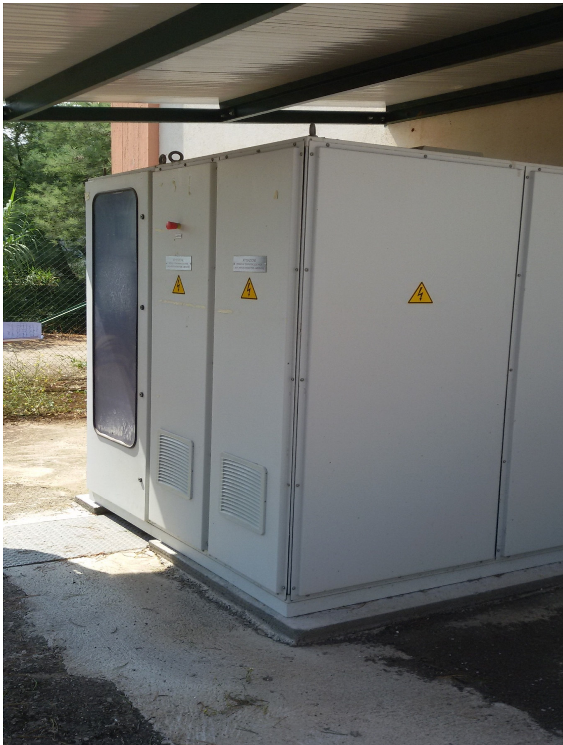
Figura 16 – Quadro di rifasamento MT 6 Kv da sostituire "Lotto 2"
