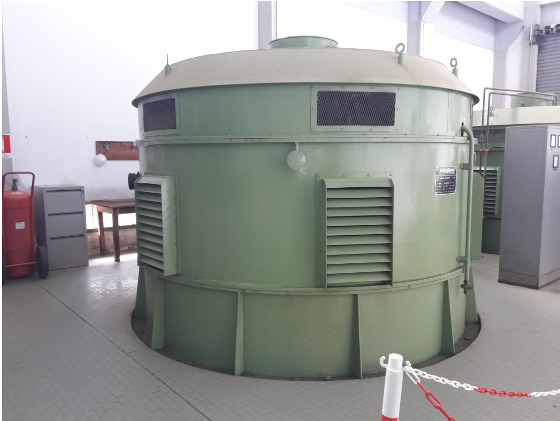
Figura 4 – motore elettrico Savignano EP1 4.400 kW da sostituire "lotto 1B"
