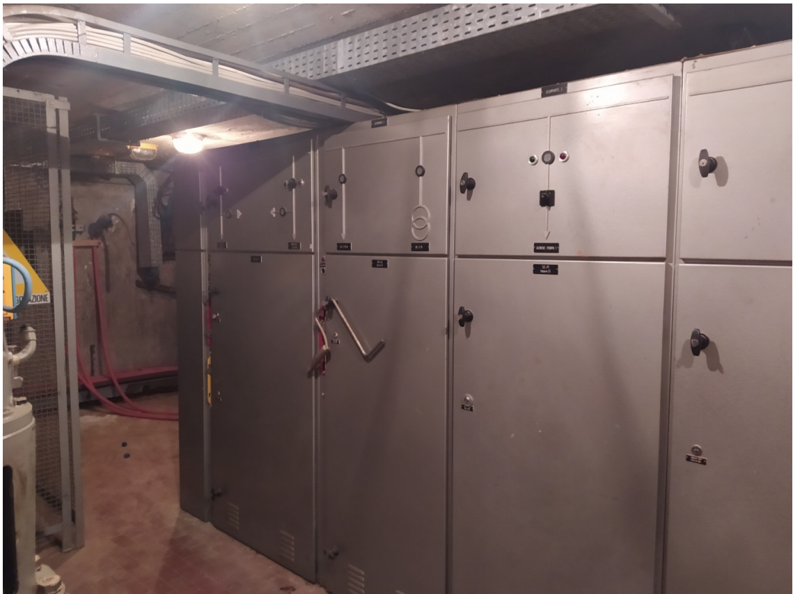
Figura 9 – Scomparti in media tensione sezione 6 Kv quadri elettrici di sezionamento e protezione da utilizzare per alimentare i motori Lotto1B e poi sostituire con nuovo avviamento Softstart/Inverter "Lotto 2-3"
