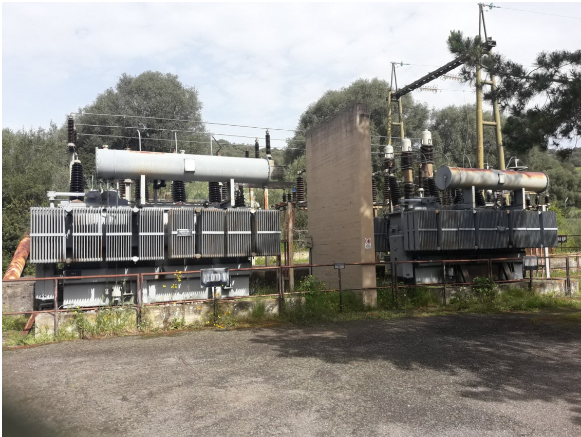
Figura 15 – Sottostazione AT da cessare è prevista una nuova fornitura di energia in MT “Lotto 2-3”
