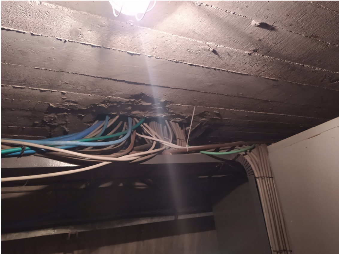
Figura 11– Cavidotti e cavi dei circuiti ausiliari delle protezione dei motori da integrare o sostituire o installare nuovi “Lotto1B”
