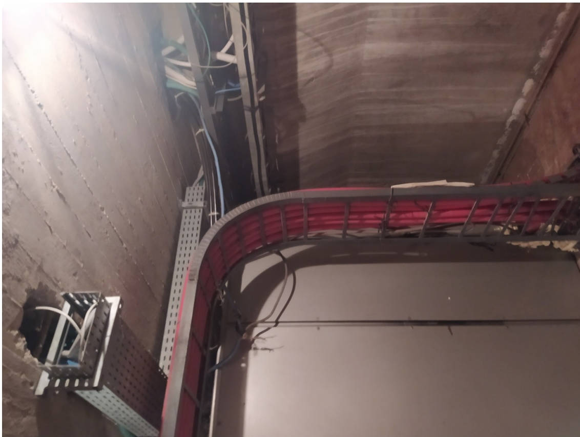
Figura 10– Cavidotti delle dorsali di alimentazione motori in media tensione da sostituire "Lotto 2-3" e cavi da sostituire per alimentare i nuovi motori "Lotto1B"
