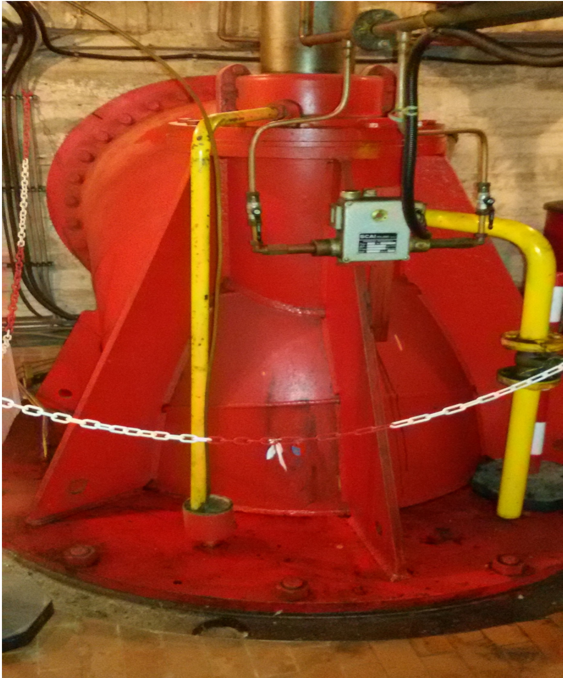
Figura 5 – gomito " bocca di scarico pompa 1 e 2 " da revisionare "Lotto 1B"
