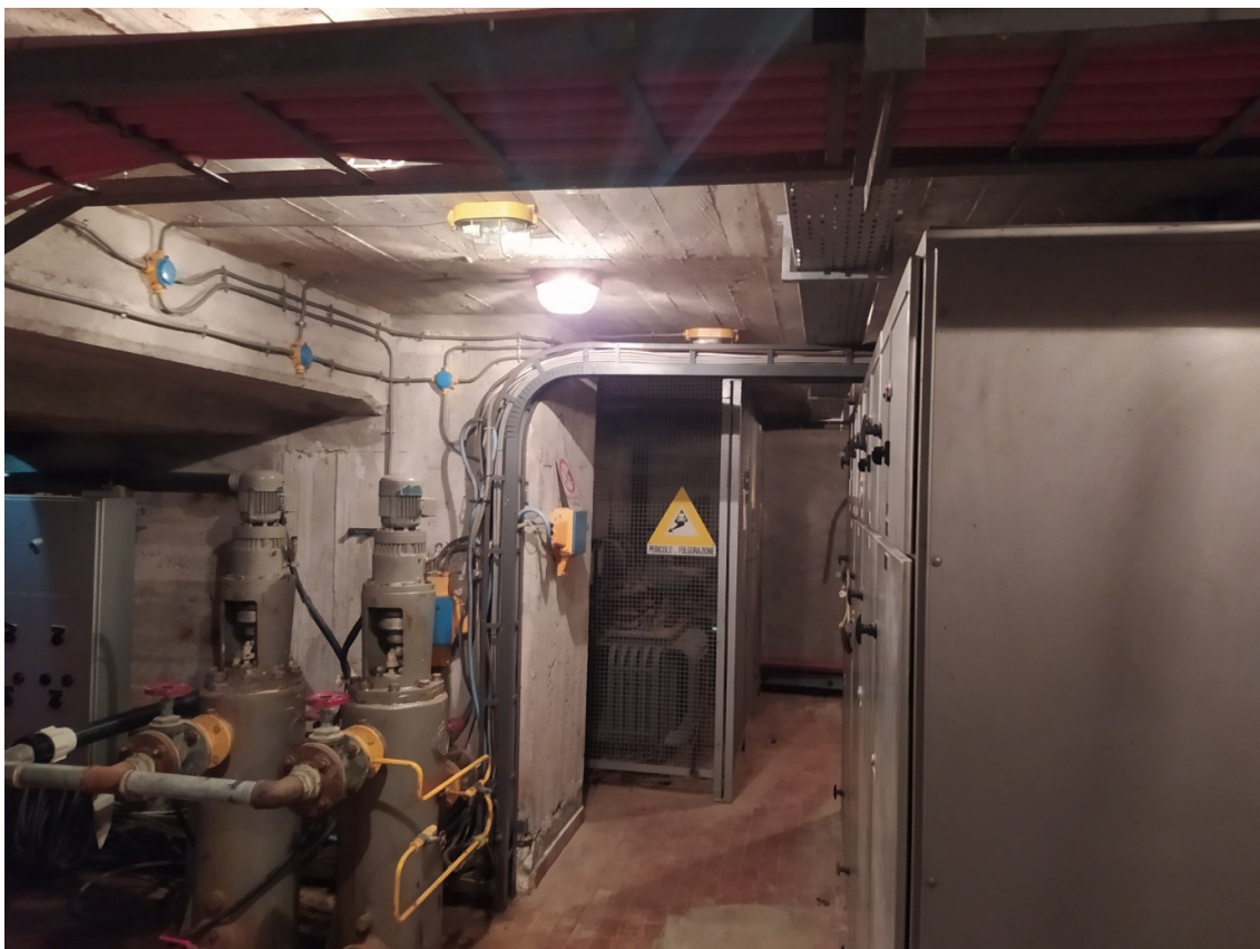
Figura 12 – elettropompe circuiti ausiliari acqua di raffreddamento cuscinetti EP1/EP2 da demolire "Lotto 1B"
