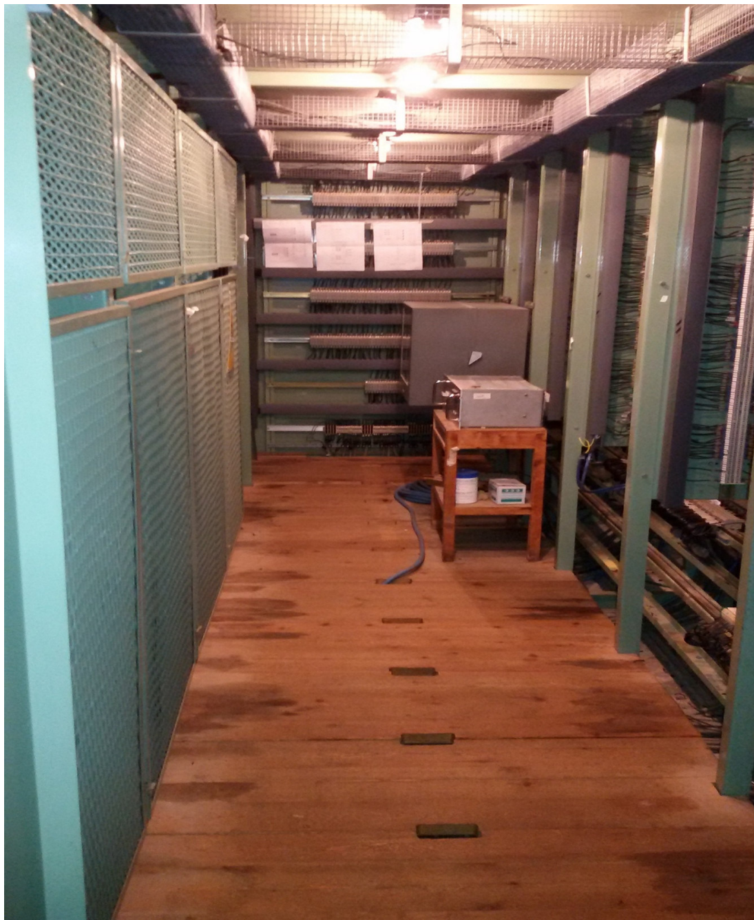
Figura 8– Quadro elettrico "parte interna" protezioni e avviamento elettropompe EP1/EP2 logica elettromeccanica da sostituire "Lotto 2-3"
