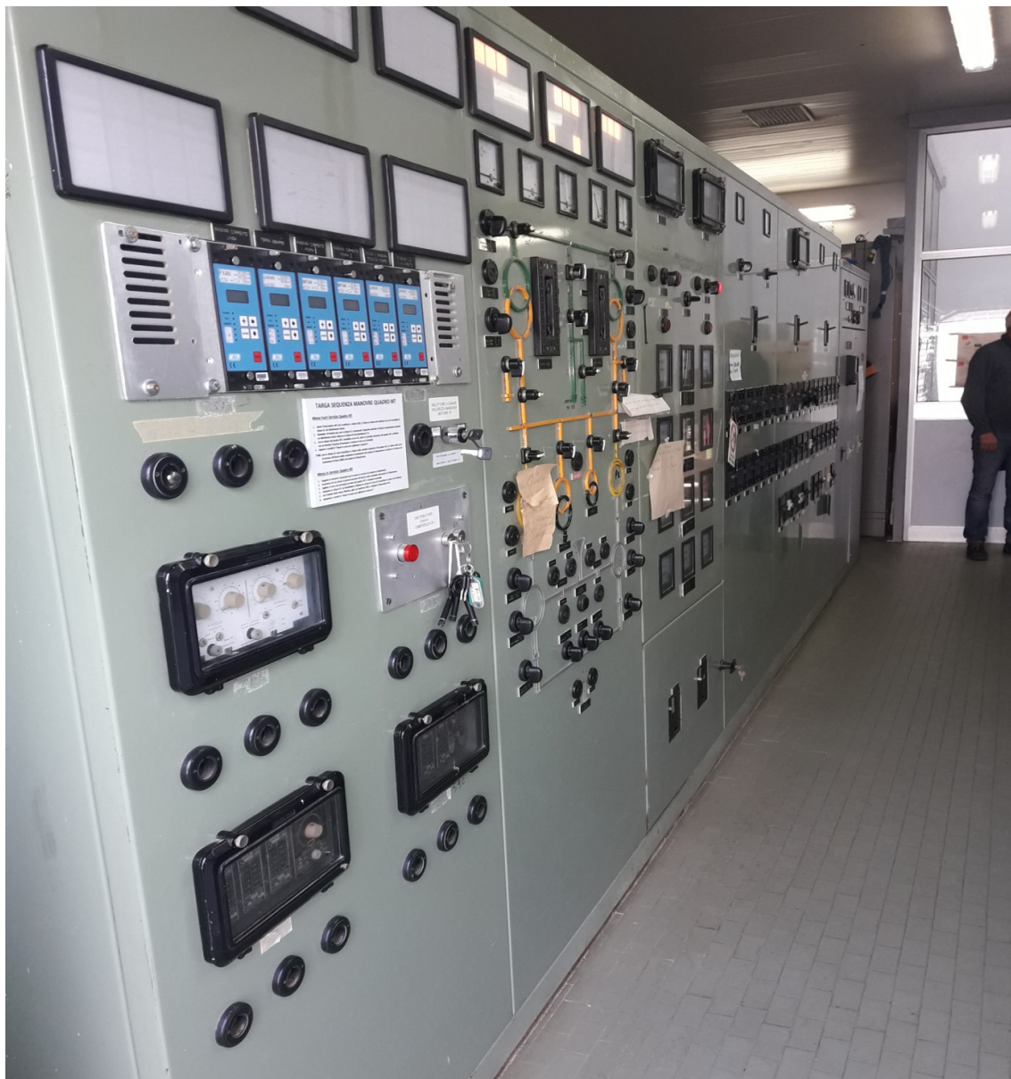
Figura 6— quadro protezioni avviamento elettropompe EP1/EP2 logica elettromeccanica da sostituire "Lotto 2-3"
