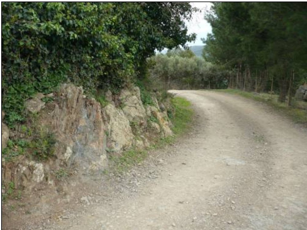
Foto 4 – Scarpata rocciosa in metapeliti – Sezione 34
