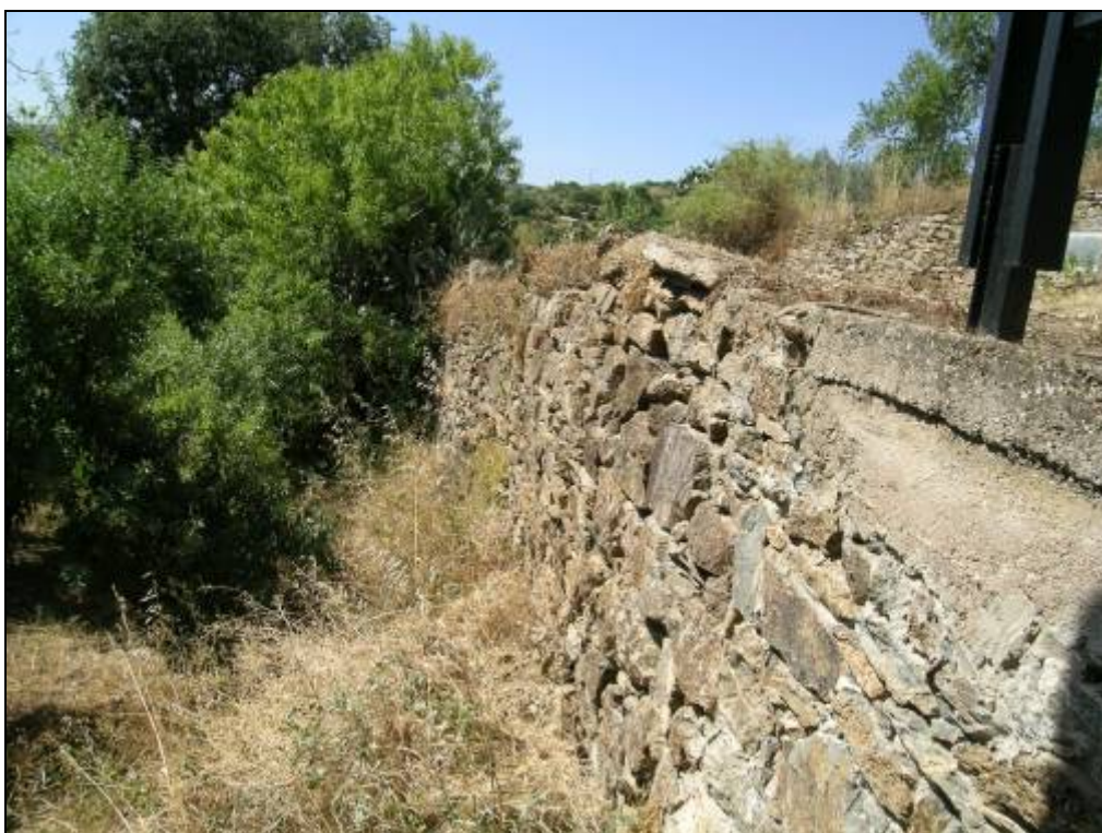
Foto 9 – Uno dei muri di sostegno in pietrame lungo la Via Marconi
