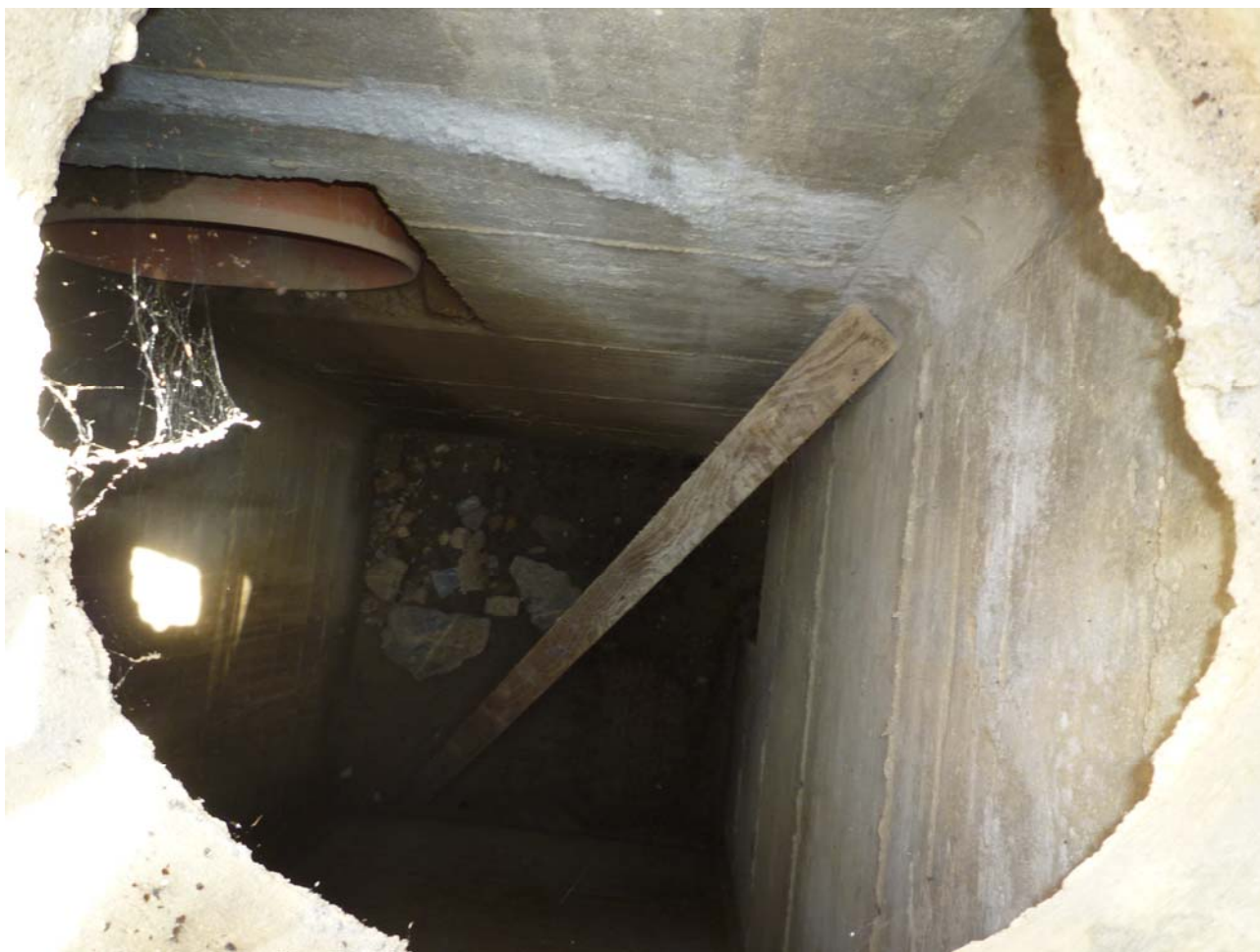
Pozzetto esistente ove viene indirizzato il nuovo collettore.
