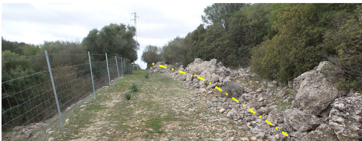
Figure 11: ricarica di blocchi rocciosi sul lato della condotta (traccia in giallo)
