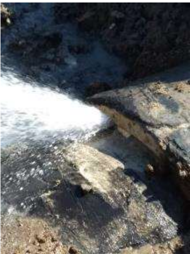
Perdita tipo su giunto tubo DN 1400
