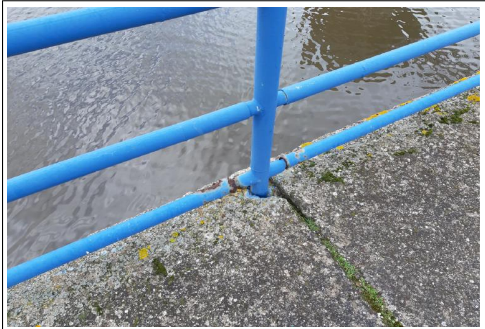
Vista del parapetto della passerella del torrino di presa n. 2 - risanamento delle parti ammalorate del parapetto e sua tinteggiatura.
