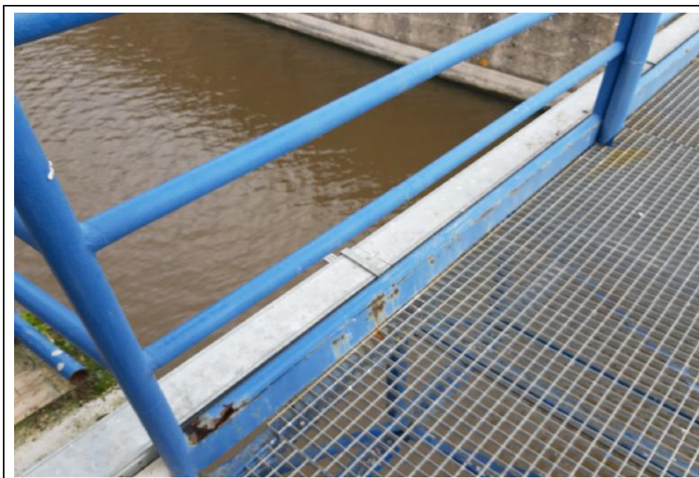
Vista della passerella (Torrino 1) particolare - risanamento delle parti ammalorate del parapetto e sua tinteggiatura.
