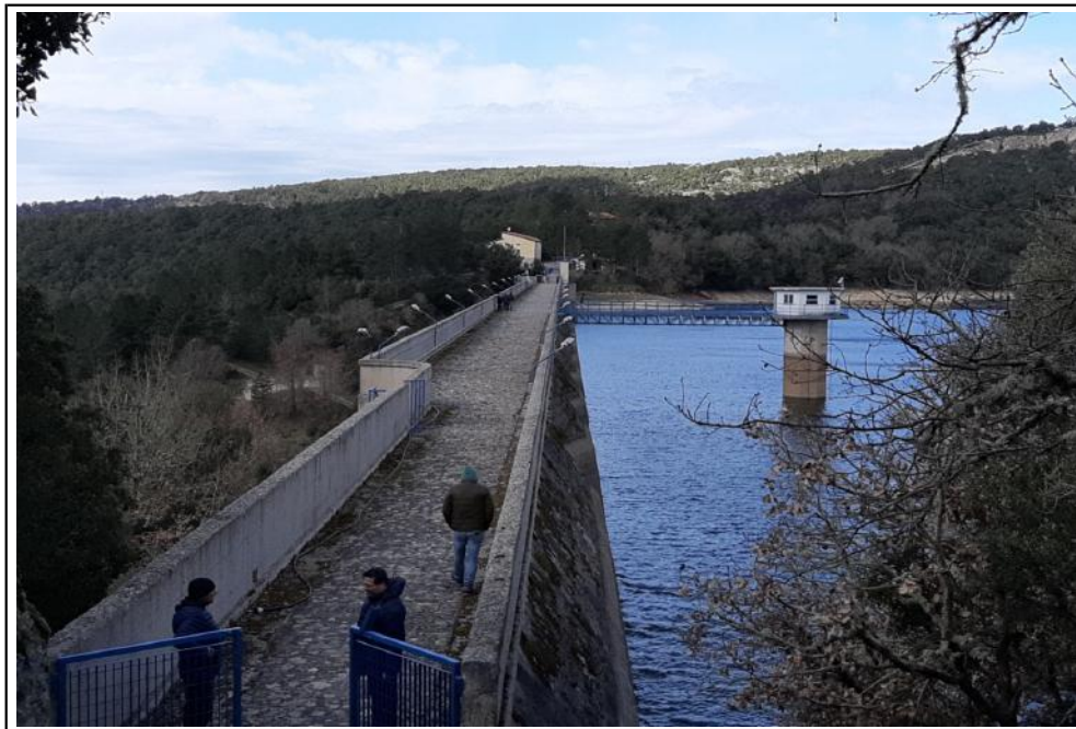
Vista passerella Torino di presa - ripristino piano di calpestio passerella torino.
