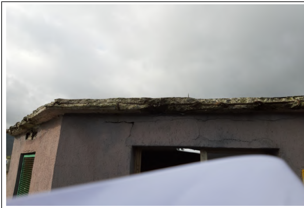
Vista sopra solaio di copertura Torrino 1 - ripristino perimetrale del solaio di copertura e pulizia del ferro di armatura.
