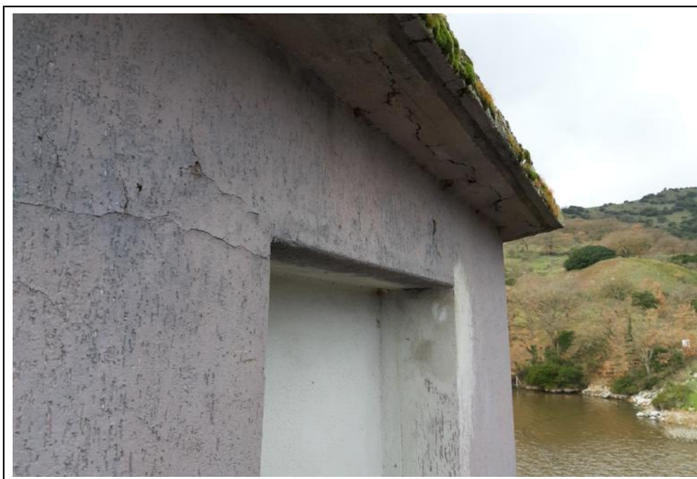
Vista sopra solaio di copertura e sulla parete esterna del Torrino 1 - ripristino perimetrale del solaio di copertura e pulizia del ferro di armatura; - ripristino parti murarie esterne del manufatto e tinteggiatura.
