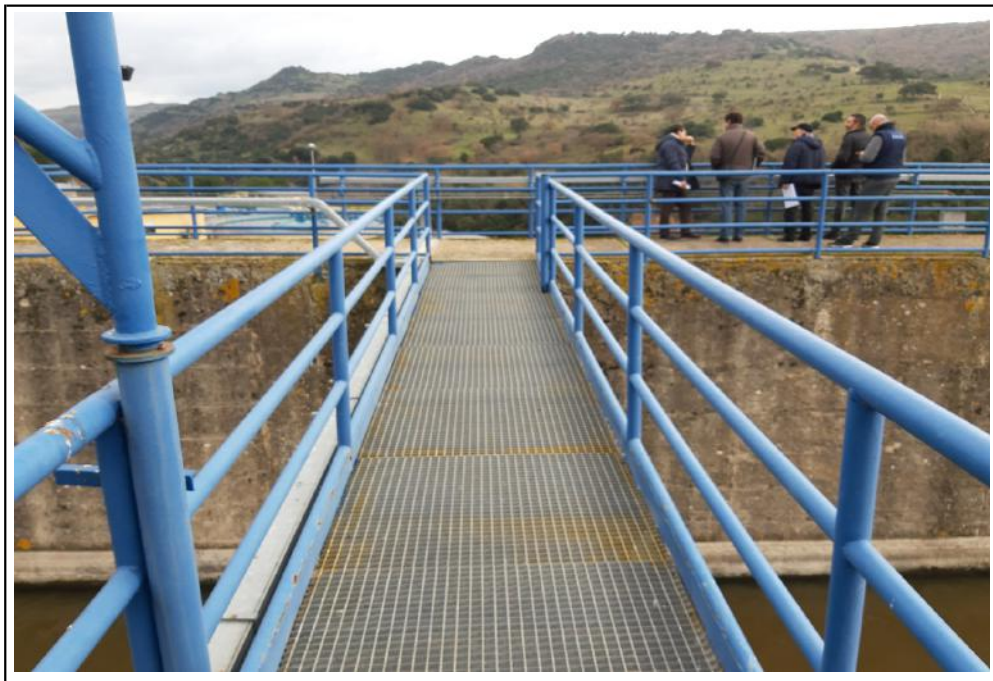
Vista della passerella (Torrino 1) verso il coronamento - risanamento delle parti ammalorate del parapetto e sua tinteggiatura.
