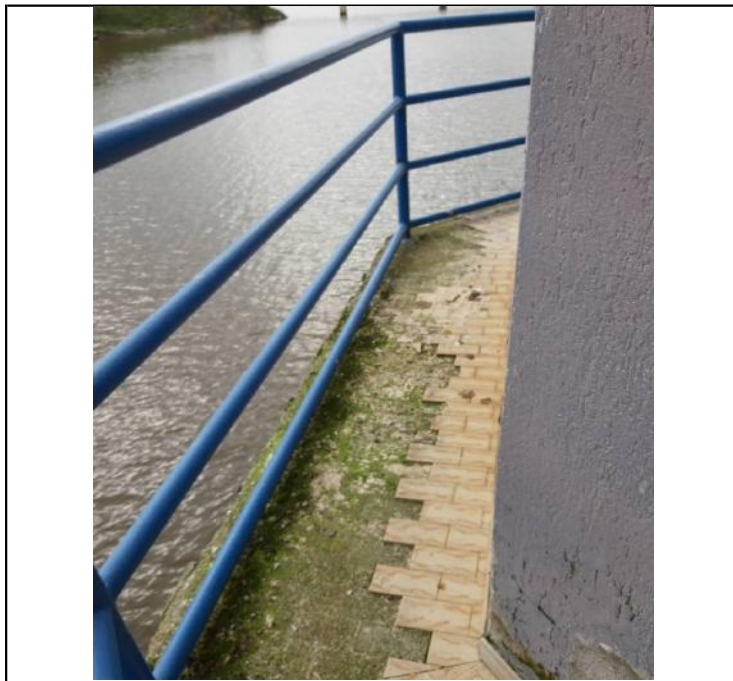
Vista sulla pavimentazione esterna del Torrino 1 - rifacimento perimetrale della pavimentazione esterna.
