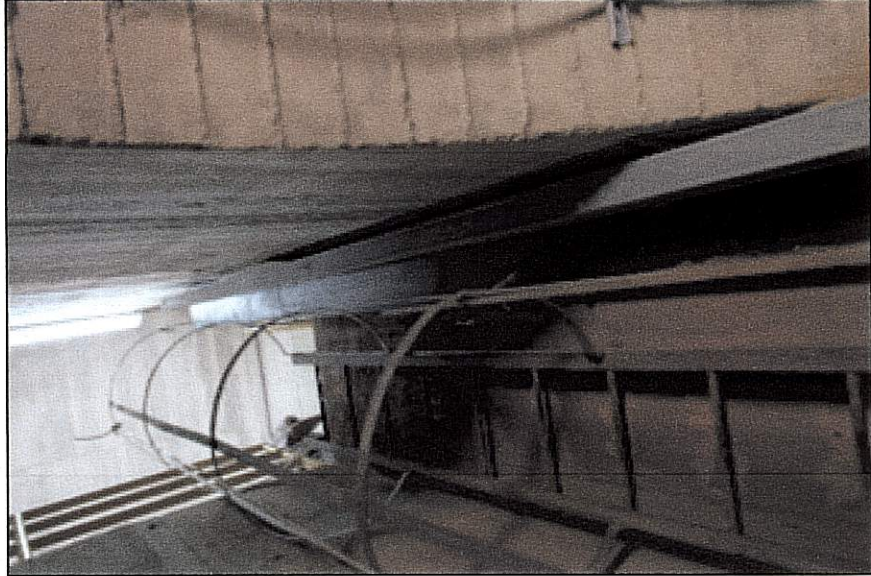
VISTA CUNICOLO DI COLLEGAMENTO TRA SALA MECCANISMI E CUNICOLO DI ACCESSO DOVE ANDRANNO LEGATI IL QUADRO ELETTRICO E LA NUOVA CENTRALINA TUBAZIONI OLEODINAMICHE DA ALENARE E CANALINA ESISTENTE IN ACCIAIO INOX PER PASSAGGIO CAVI PROFIBUS
