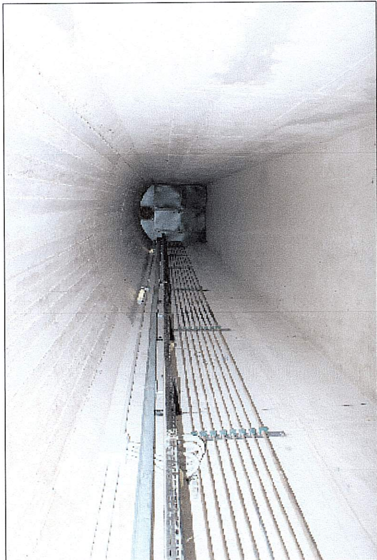
PRIMA VISTA CUNICOLO DI ACCESSO CON VITI VECCHIE TUBAZIONI OLEODINAMICHE DA ALENARE E CANALINA ESISTENTE IN ACCIAIO INOX DA UTILIZZARE PER PASSAGGIO CAVI ELETTRICI
