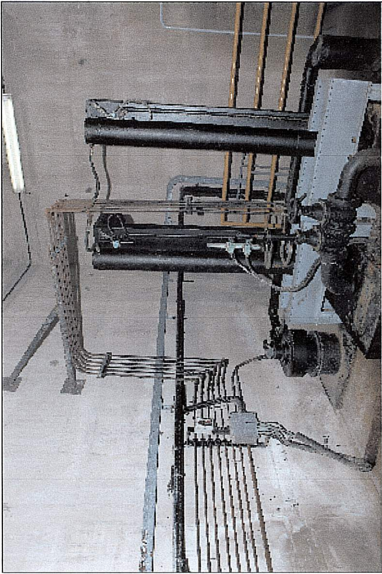
VISTA CAMERA MECCANISMI CON PARATIE DA RIVESTIRE MEDIANTE CORDINI IN ACCIAIO INOX. VISTA VECCHIE TUBAZIONI OLEODINAMICHE DA ALIENARE, STAFFA DI SOSTEGNO DA RIMUOVERE E CANALINA ESISTENTE IN ACCIAIO INOX PER PASSAGGIO CAVO PROFIBUS
