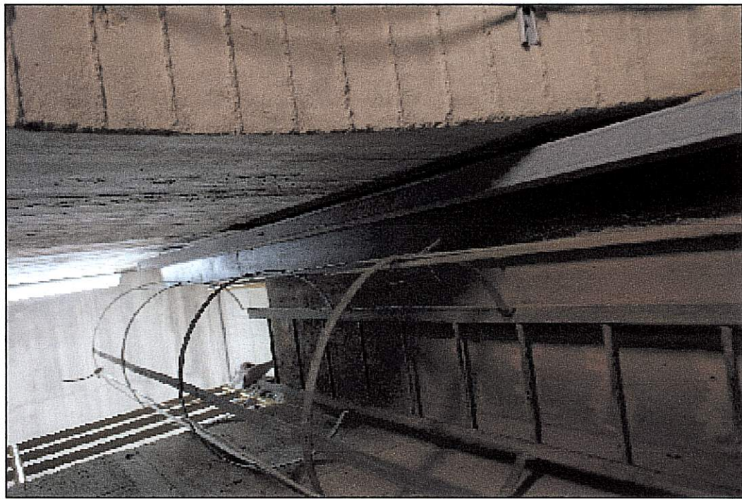
VISTA CUNICOLO DI COLLEGAMENTO TRA SUA CAMERA MECCANISMI E CUNICOLO SOTTOSTANTE CON EVIDENZA CAVI IN ACCIAIO INOX ESISTENTE DA UTILIZZARE PER PASSAGGIO CAVI PROFIBUS
