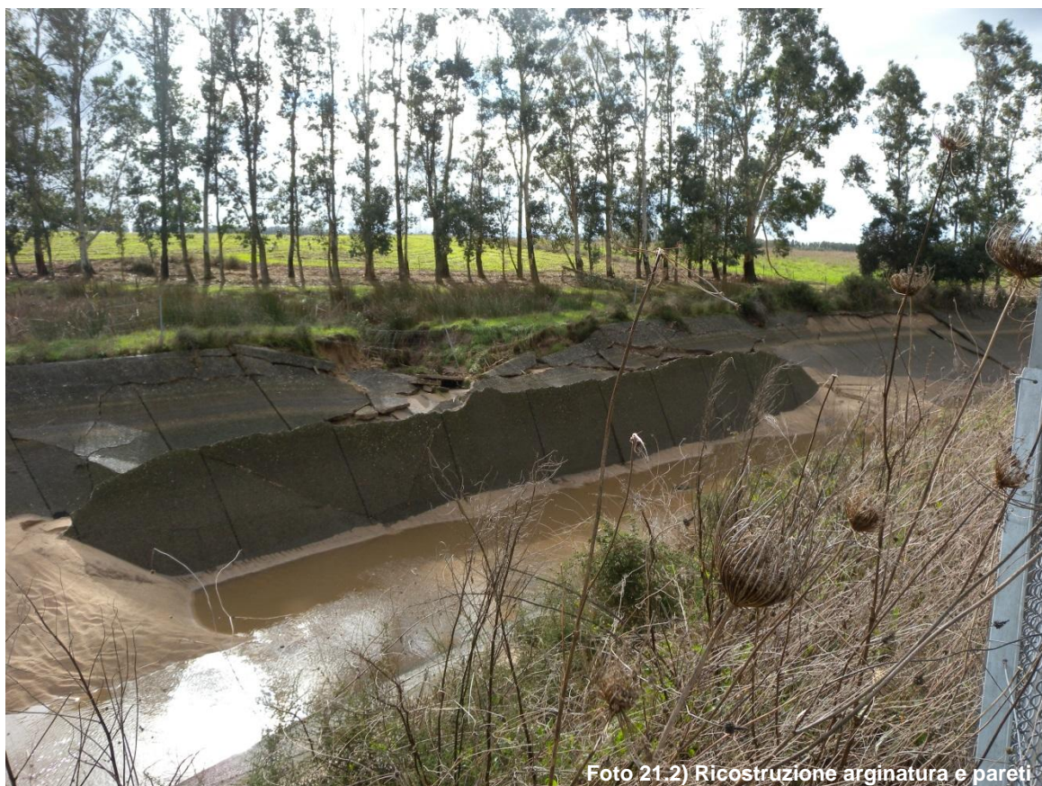
Foto 21.1) Ricostruzione arginatura e pareti
