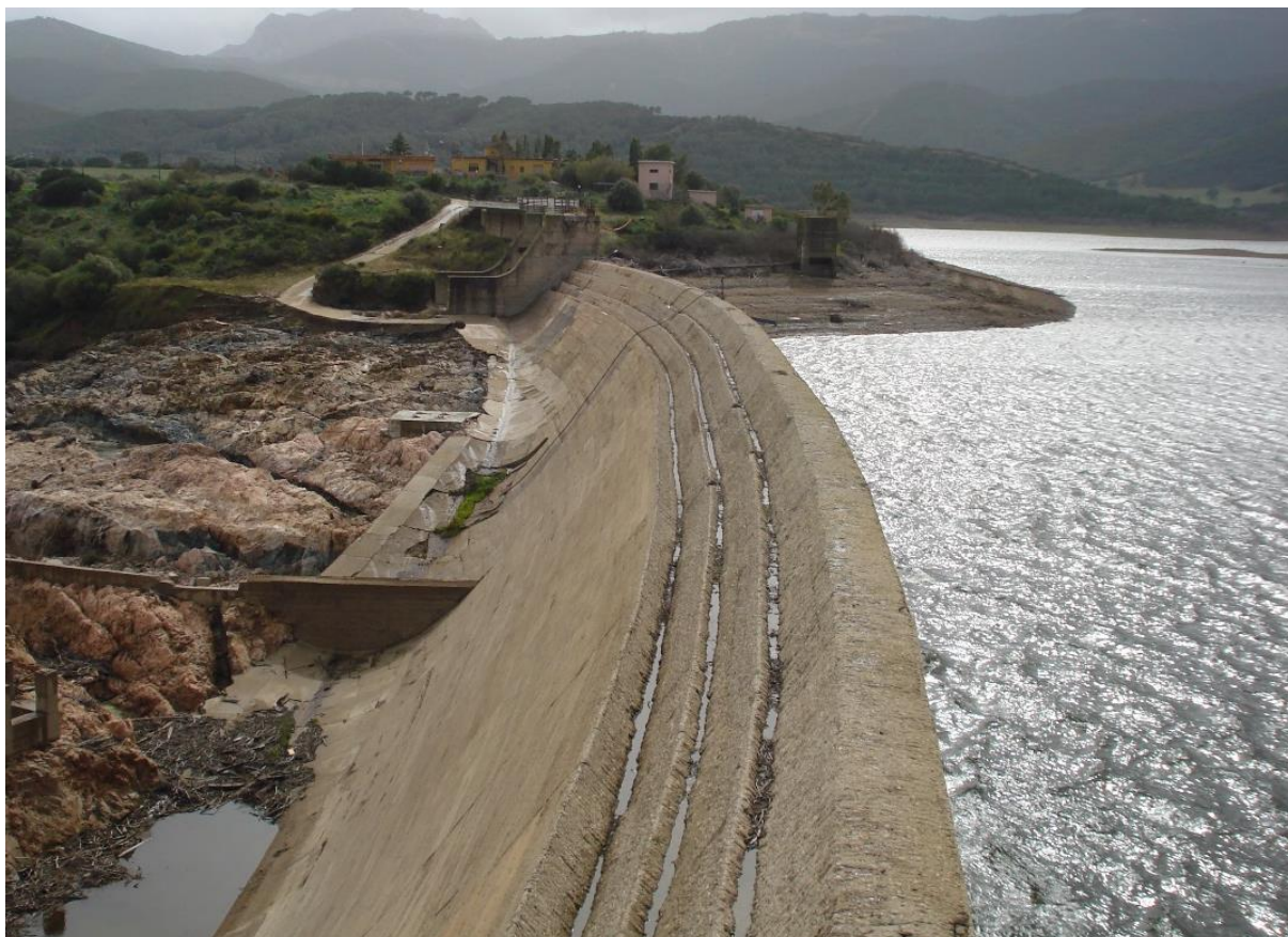
Profilo dello sbarramento a seguito dei lavori – Configurazione attuale
