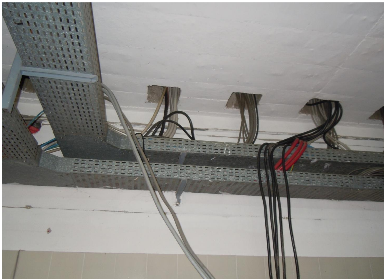
Passaggio cavi ai Quadri MT e Vano Trasformatori
