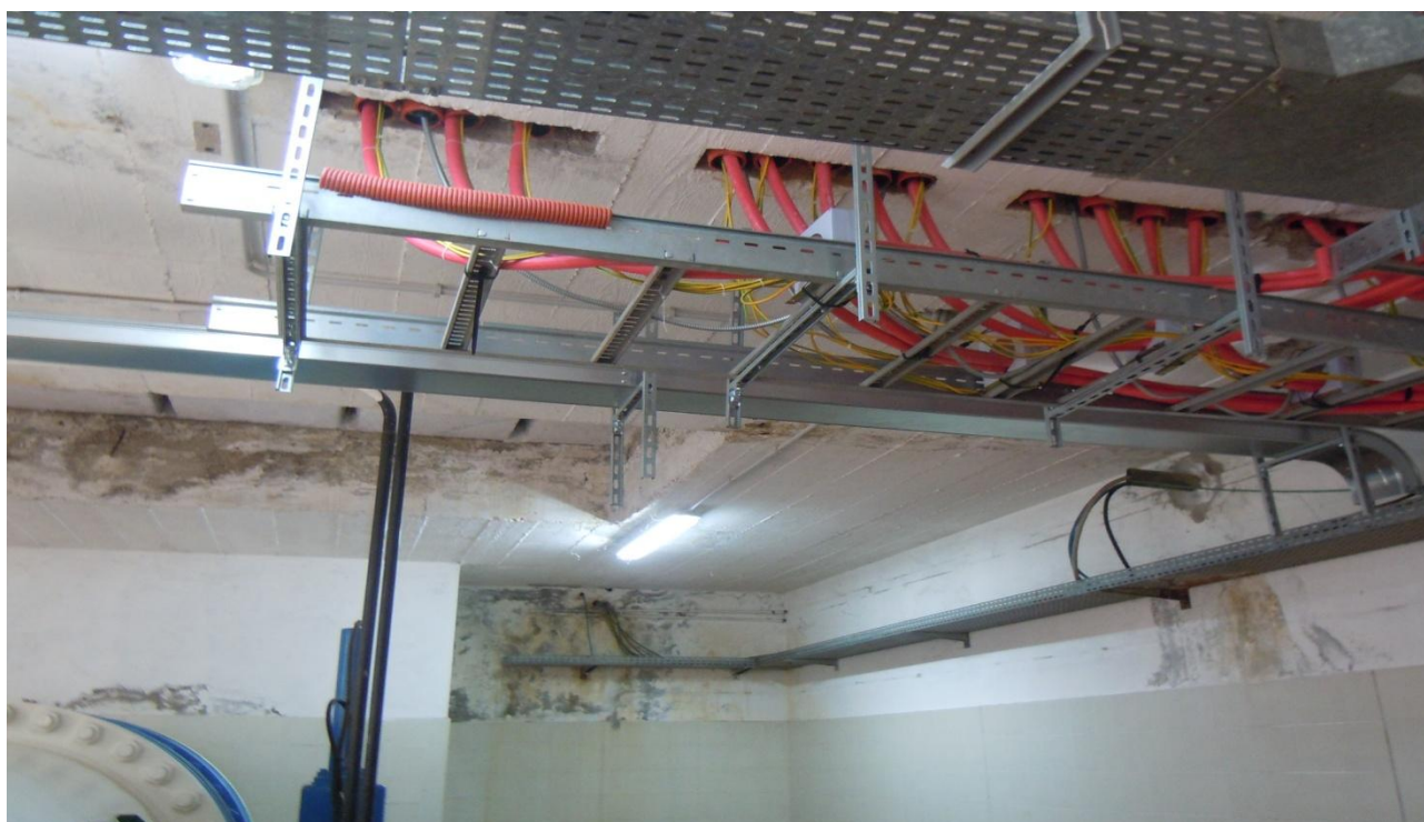
Passaggio cavi ai Quadri MT e Vano Trasformatori
