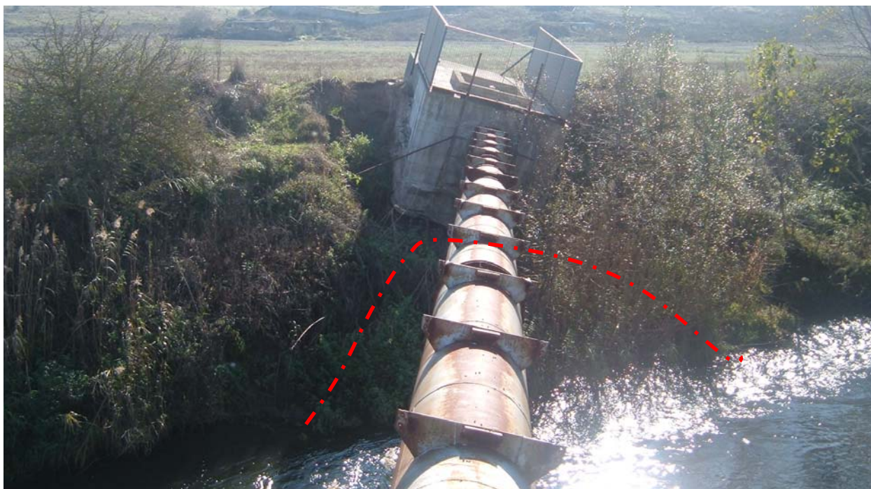
Figura 3. Stato attuale del blocco in dx idraulica: evidente il basculamento e la nicchia di erosione (in rosso) alla base della fondazione.
