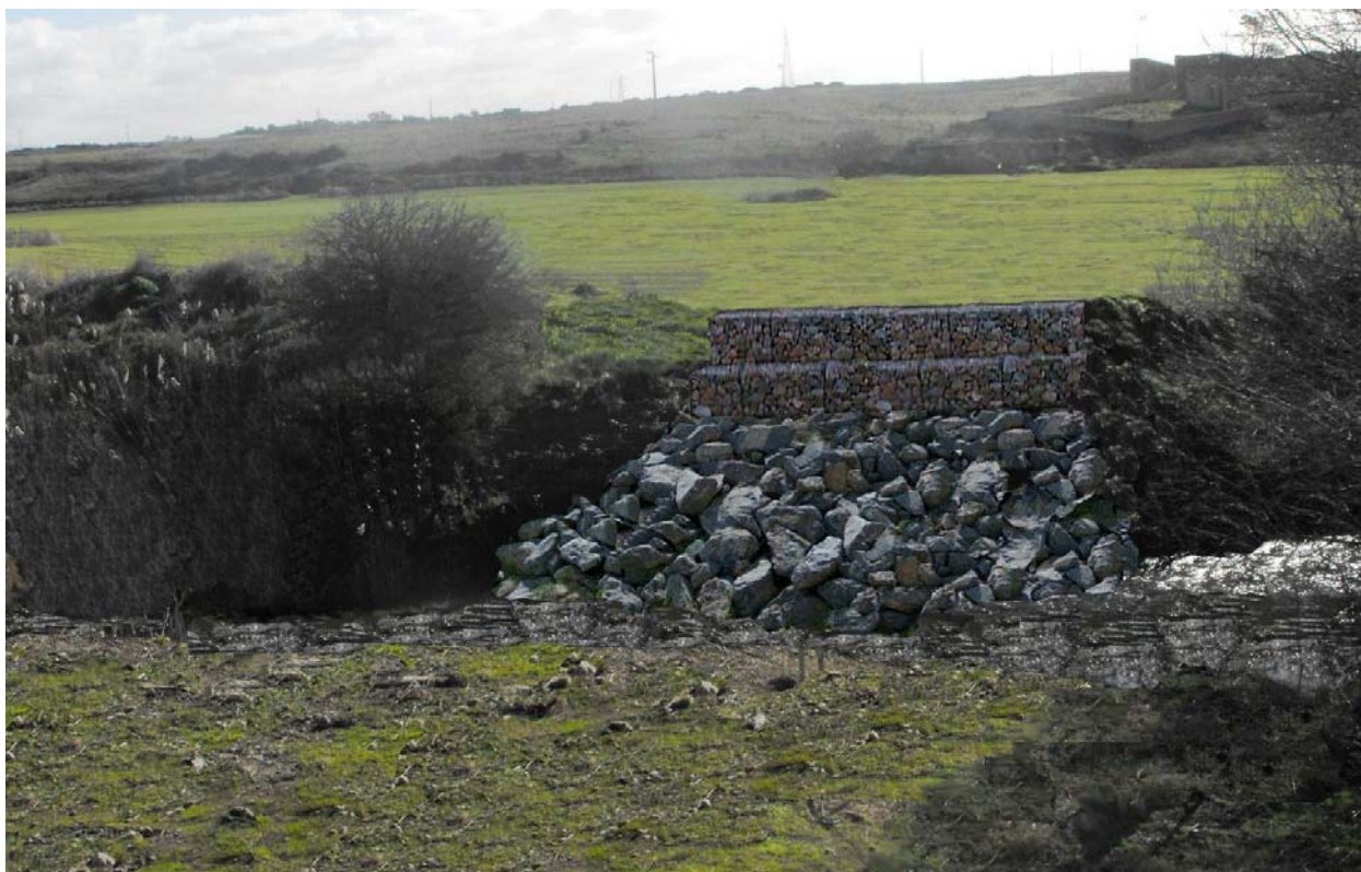
Figura 26. Fotoinserimento della possibile soluzione di risistemazione e protezione della sponda dx su cui era alloggiato il blocco in dissesto. l'intervento è rappresentato senza l'inerbimento conclusivo.
