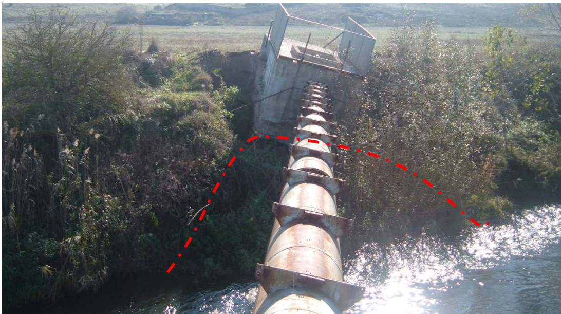
Figura 1 Stato attuale del blocco in dx idraulica: evidente il basculamento e la nicchia di erosione (in rosso) alla base della fondazione.
