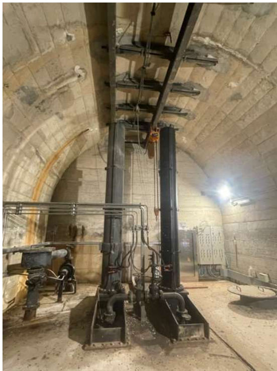
vista dei due carriponte posizionati all'interno della torre
