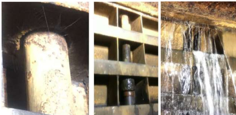
dettaglio del danno arrecato dall'asta di manovra alla struttura della paratoia e della perdita di acqua generata dalla falla
