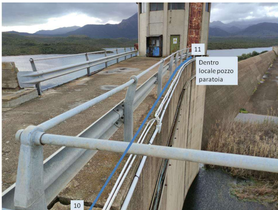
foto 5, 6, 7, 8, 9, 10, 11, 12: identificazione del percorso del cavidotto dal pavimento stradale (foto 5, p.to 6) alla torre (foto 12, p.to 12)
